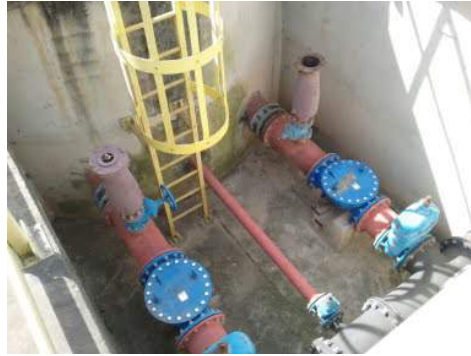
Descrição(3): Detalhe das válvulas de retenção e ventosas Imagem(4)
