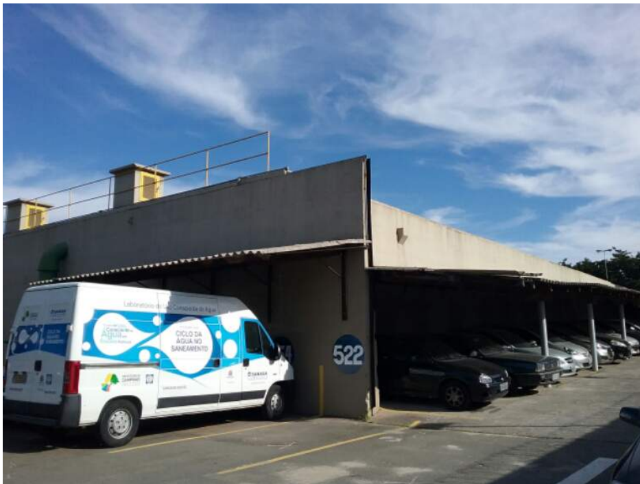
Descrição(5): Aspecto geral do reservatório. Local também é utilizado como estacionamento
