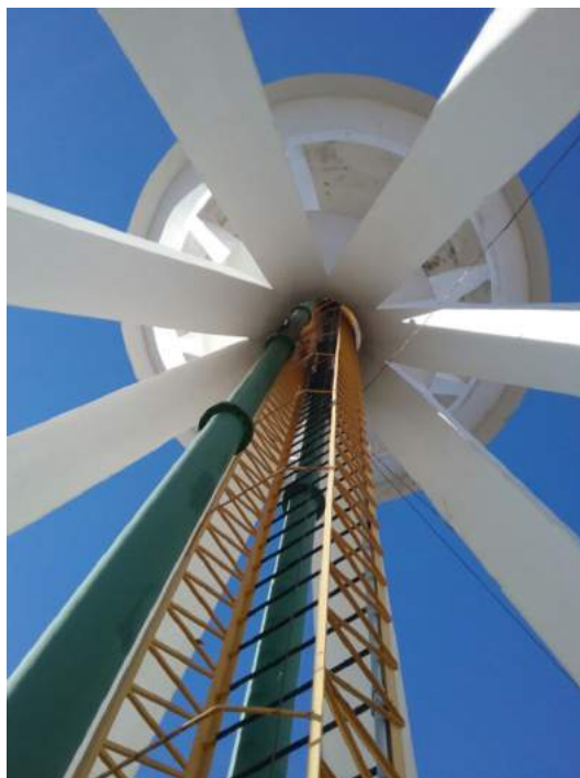
Descrição(3): Escada de acesso ao interior do reservatório
