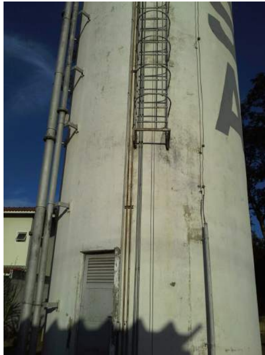
Descrição(2): Detalhe da escada com guarda-corpo e linha de ancoragem
