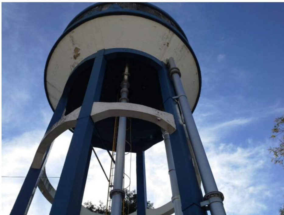
Descrição(3): Tubo extravasor à direita
