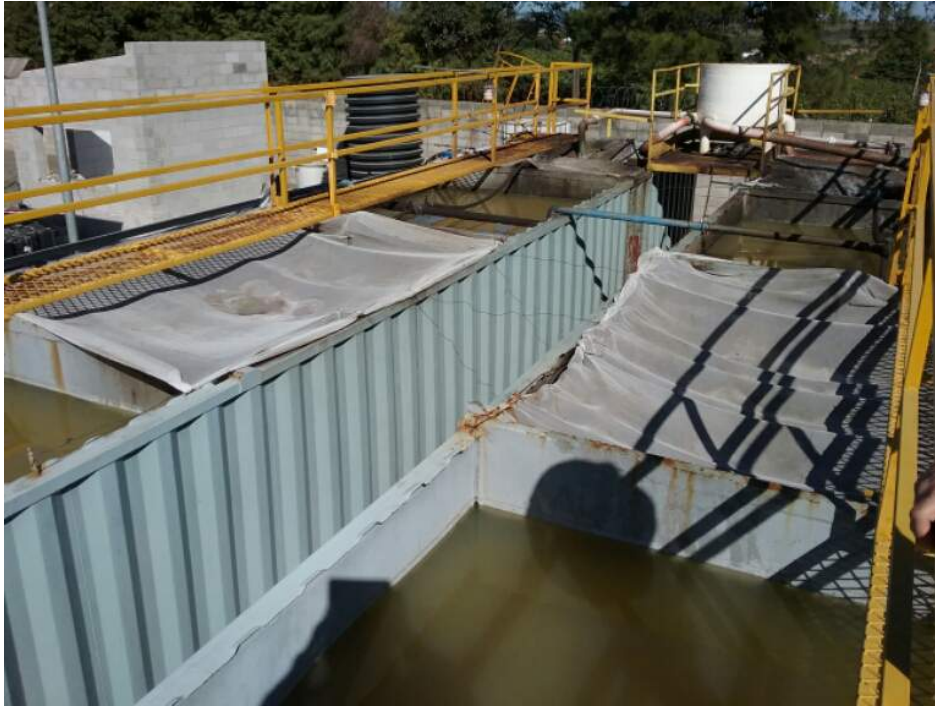
Descrição(15): Cobertura adaptada para não desprender a espuma superficial para a atmosfera Imagem(16)
