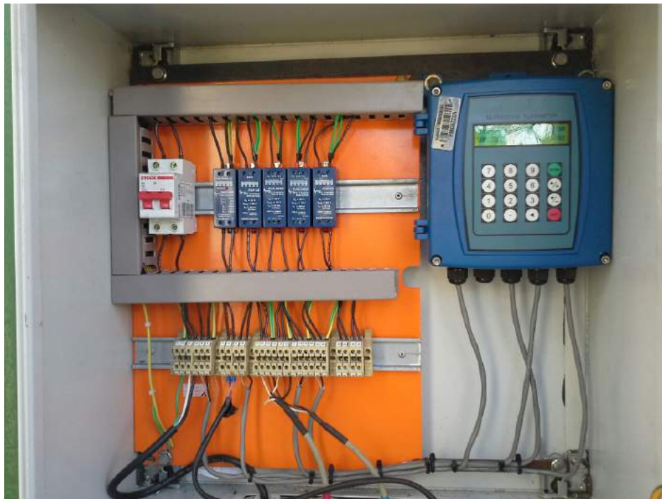
Descrição(2): Macromedidor ultrassônico
