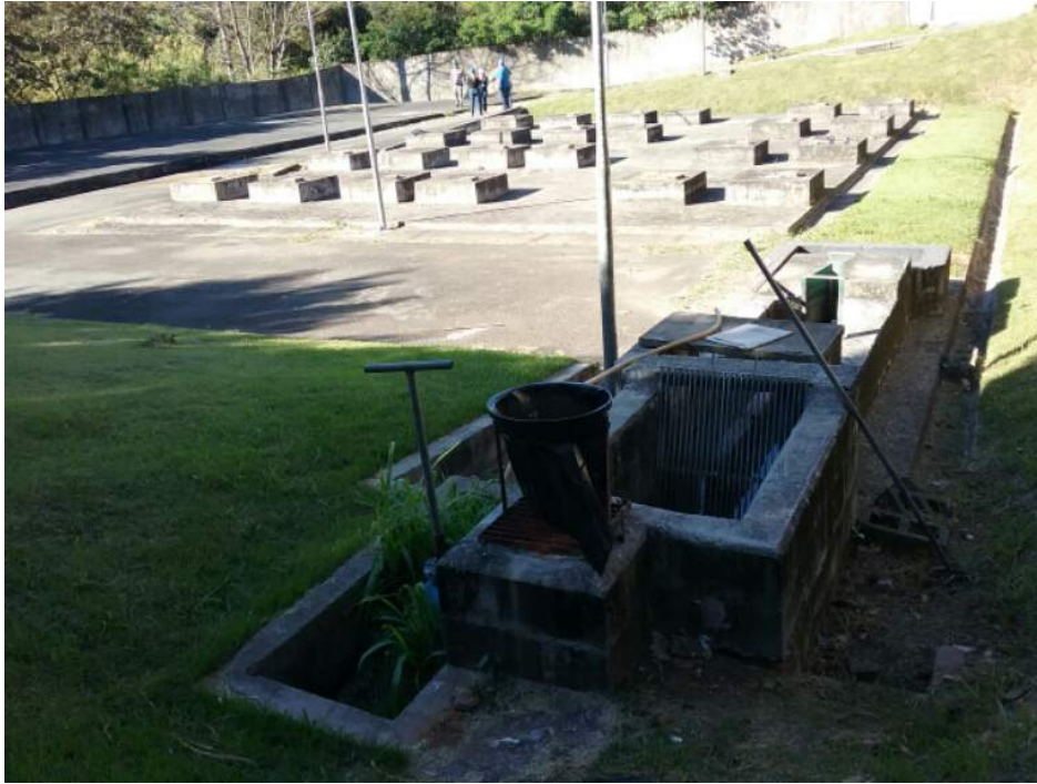
Descrição(2): Vista geral da ETE com tratamento preliminar seguido de dois módulos de tanques sépticos e de dois módulos de filtro anaeróbio
