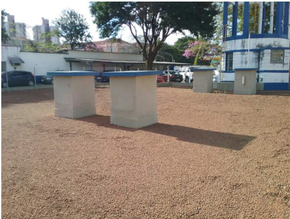
Descrição(3): Cobertura do reservatório e tubulações de ventilação
