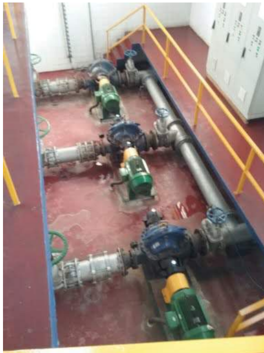
Descrição(2): Aspecto geral da elevatória
