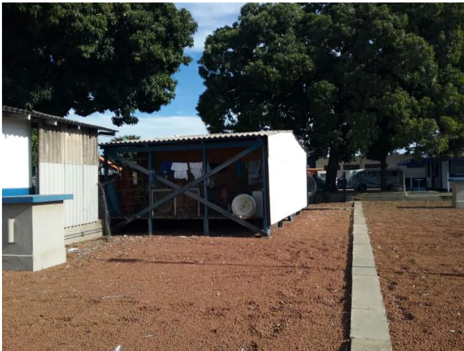
Descrição(6): Estrutura de armazenamento de materiais sobre a cobertura do reservatório
