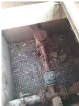
Descrição(4): Detalhe do cesto na entrada de esgoto bruto na elevatória Imagem(5)
