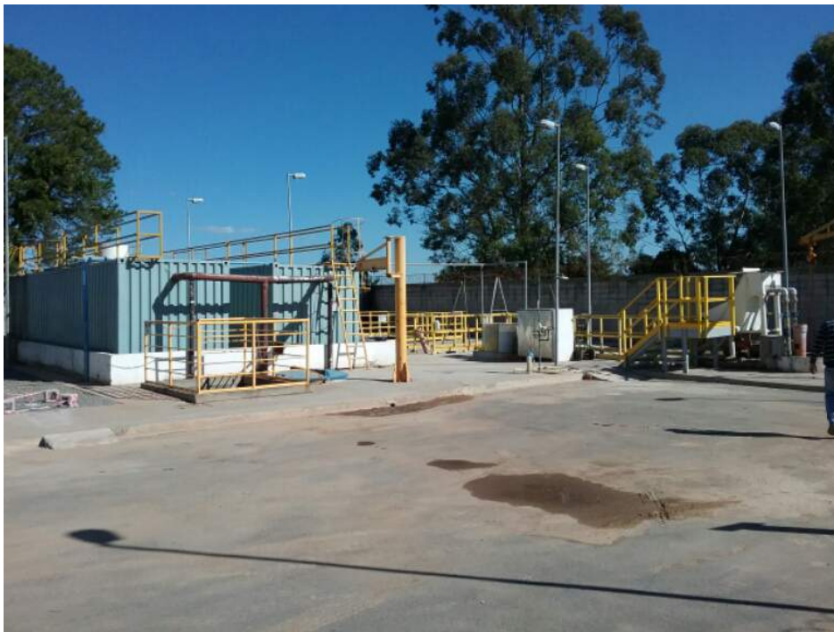
Descrição(2): Vista geral do Sistema de tratamento da ETE ABAETÉ
