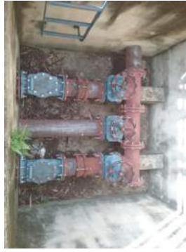
Descrição(3): Detalhe das válvulas de retenção
