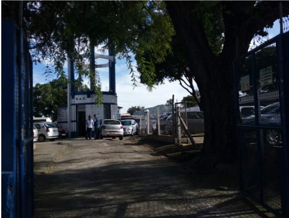
Descrição(2): Portão de acesso ao reservatório
