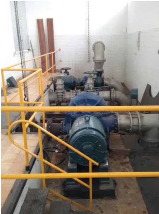
Descrição(4): Aspecto geral da elevatória
