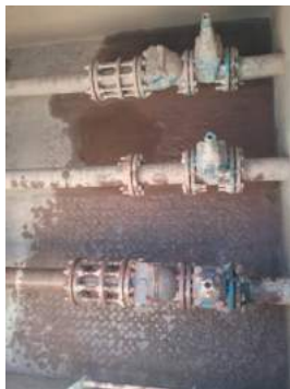
Descrição(7): Detalhe das válvulas de retenção
