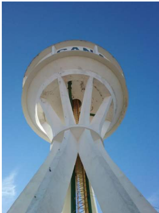
Descrição(2): Aspecto geral do reservatório
