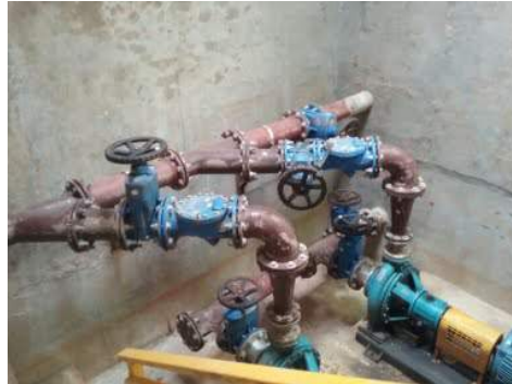
Descrição(8): Detalhe das válvulas de retenção
