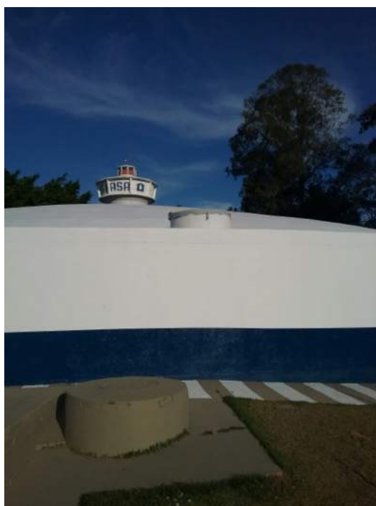
Descrição(3): Detalhe da tampa de inspeção
