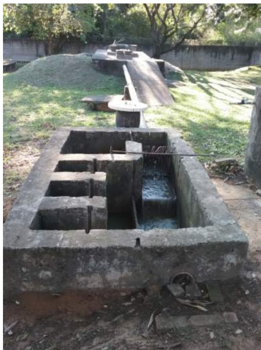
Descrição(5): Vista do tratamento preliminar da entrada do esgoto bruto até a caixa de distribuição
