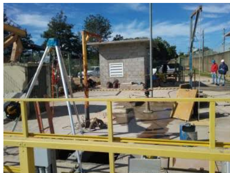
Descrição(6): Aspecto geral da elevatória em obras
