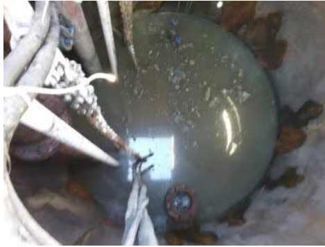
Descrição(7): Poço de recalque do esgoto bruto
