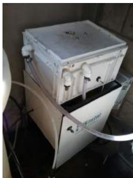
Descrição(7): Reservatório de água do desodorizador
