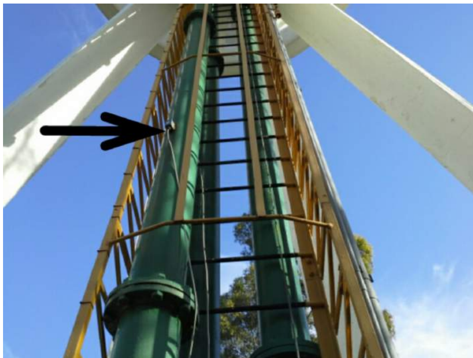
Descrição(3): Detalhe do sensor de telemetria
