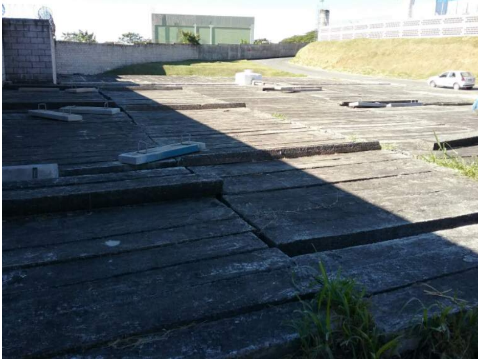
Descrição(7): Detalhes das placas de concreto armado da tampa do tanque séptico
