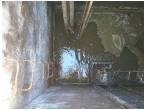
Descrição(3): Detalhe da escada de acesso ao interior da elevatória
