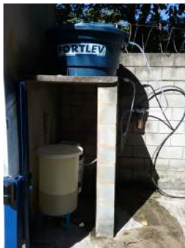
Descrição(7): Reservatório de água do desodorizador
