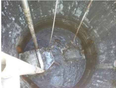
Descrição(7): Poço de recalque do esgoto bruto
