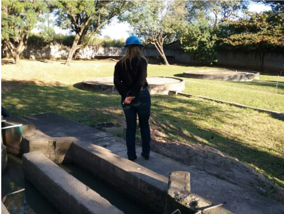
Descrição(2): Destaque do tratamento preliminar e ao fundo dois tanques sépticos circulares
