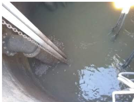
Descrição(5): Detalhe da válvula de retenção e da ventosa
