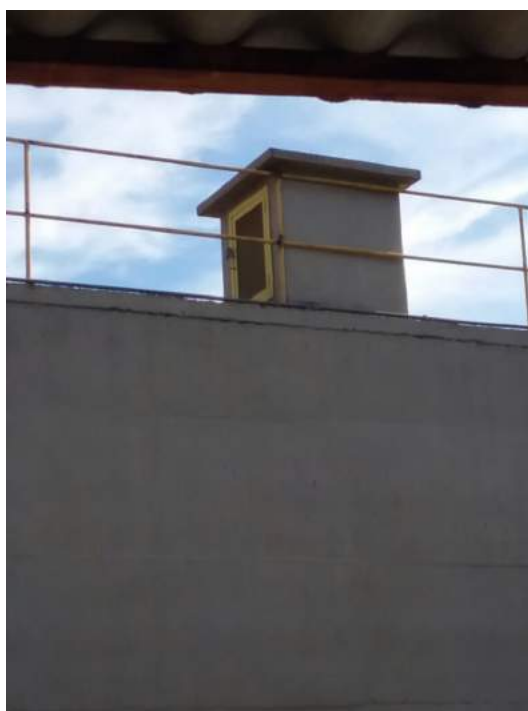
Descrição(3): Guarda corpo em parte da cobertura do reservatório
