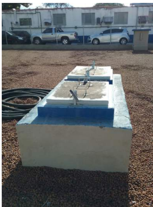
Descrição(7): Detalhe das tampas de inspeção
