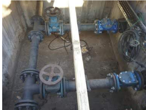
Descrição(4): Detalhe das válvulas de retenção
