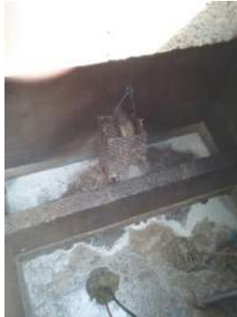
Descrição(4): Detalhe do cesto na entrada de esgoto bruto na elevatória Imagem(5)
