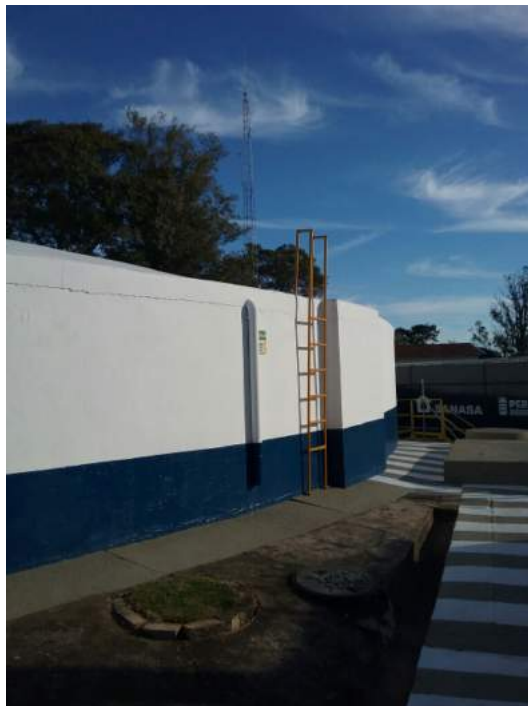
Descrição(2): Aspecto geral do reservatório
