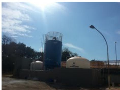
**Descrição(10):** Tanque de armazenamento de produtos químicos (Hipoclorito de sódio, hidróxido de cálcio em suspensão e sulfato de alumínio), com sistema de contenção.
