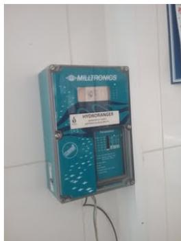
**Descrição(1):** Display do medidor de vazão
