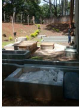
Descrição(3): Poço de sucção e casa de bombas subterrânea que trabalham afogadas Imagem(4)
