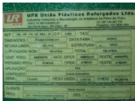
Descrição(9): Placa de identificação de um dos Filtros Biológicos com algumas características de projeto
