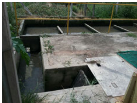
Descrição(9): Outra vista do tanque de contato
