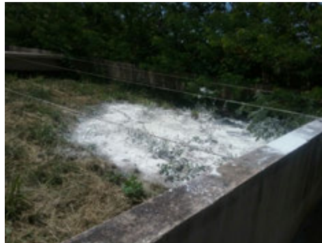
Descrição(15): Caixa de desidratação de lodos
