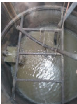
Descrição(3): Caixa de retenção de gorduras após o tratamento preliminar e antes da EEE que recalca para a ETE
