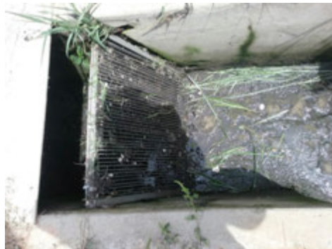
Descrição(8): Gradeamento fino que retém os sólidos em suspensão na saída do efluente tratado
