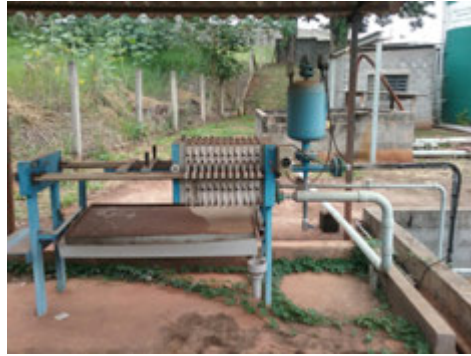
Descrição(1): Presa desagua doravante de lodo desativada, retira o lodo com caminhões limpa fossa Imagem(2)
