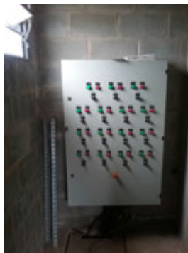
Descrição(15): Painel elétrico de comando dos conjuntos moto-bombas
