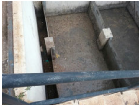
Descrição(3): Caixa de retenção de gorduras após o tratamento preliminar e antes da EEE que recalca para a ETE
