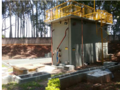
Descrição(3): Poço de sucção e casa de bombas subterrânea que trabalham afogadas Imagem(4)
