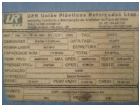
Descrição(9): Placa de identificação de um dos Reatores UASB e especificações de projeto
