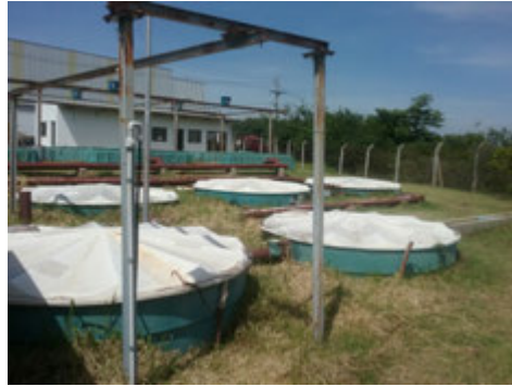
Descrição(10): Vista geral dos Reatores aeróbicos ao fundo e decantadores
