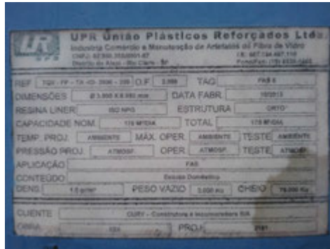
Descrição(8): Placa de identificação de um dos Filtros Biológicos com algumas características e especificações de projeto
