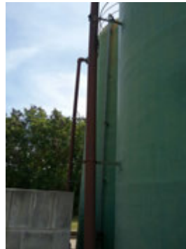
Descrição(15): Detalhes de algumas tubulações de interligação dos Reatores UASB e Filtros Biológicos
