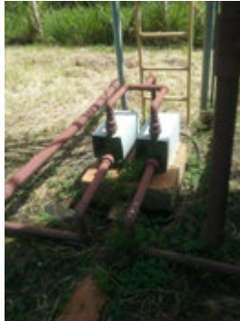
Descrição(7): Bombas de Recirculação de lodo
