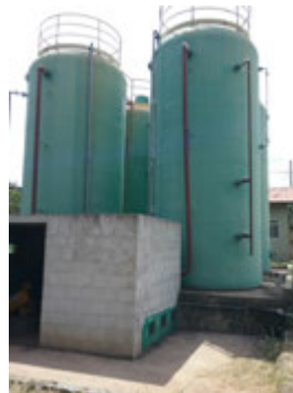
Descrição(16): Sala dos sopradores e ao fundo os Reatores UASB e Filtros Biológicos perfilados
