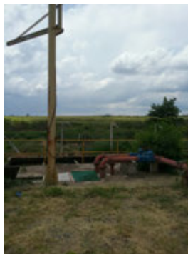
Descrição(12): Guindaste para a retirada das bombas submersas do poço
