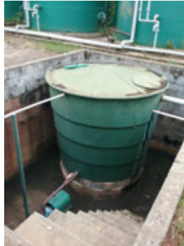
Descrição(1): Presa desagua doravante de lodo desativada, retira o lodo com caminhões limpa fossa Imagem(2)
