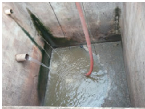
Descrição(4): EEEB após o tratamento preliminar
