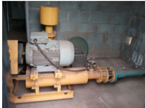
Descrição(14): Detalhes de um dos conjuntos comprssor-soprador
