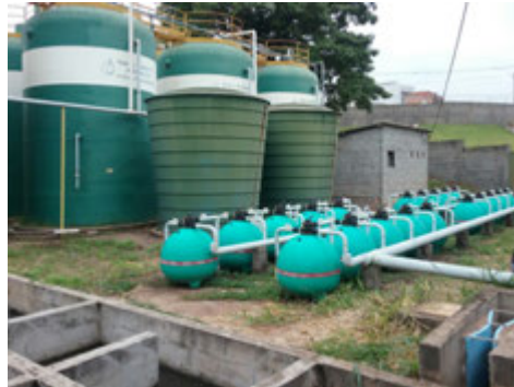
Descrição(9): Filtros de areia após decantadores e antes do tanque de contato ou lançamento do efluente tratado
