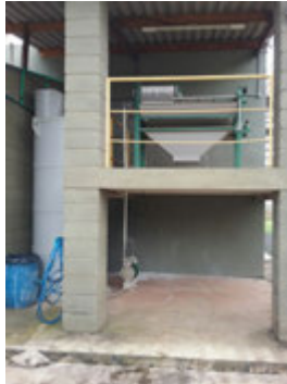
Descrição(7): Prensa desaguadora de lodo nunca utilizada, o lodo retirado por caminhão limpa-fossa
