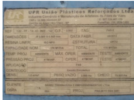
Descrição(11): Placa com as características dos tanques dos Filtros Imagem(12)
