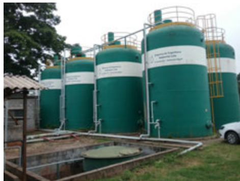
Descrição(3): ETE Compacta Reatores UASB e Filtros Biológicos perfilados Imagem(4)
