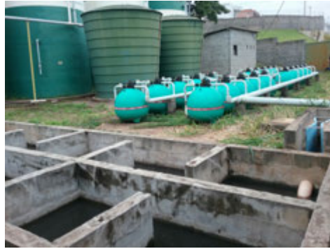
Descrição(9): Filtros de areia após decantadores e antes do tanque de contato ou lançamento do efluente tratado
