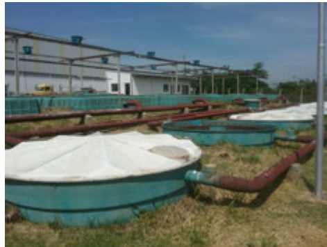
Descrição(10): Vista geral dos Reatores aeróbicos ao fundo e decantadores
