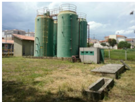
Descrição(16): Sala dos sopradores e ao fundo os Reatores UASB e Filtros Biológicos perfilados
