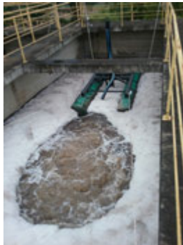
Descrição(8): Lodos ativados por batelada com aeradores
