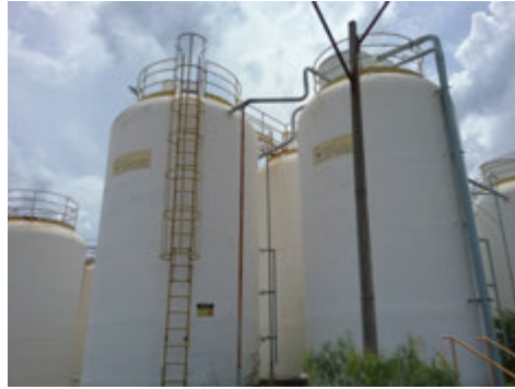
Descrição(6): Reatores UASB e Filtros Biológicos perfilados
