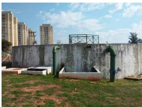
**Descrição(2):** Detalhe da entrada de água, extravasor e guarda-corpo na laje.
