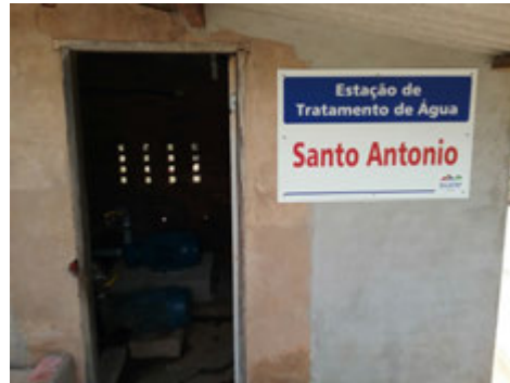
Descrição(10): Placa de identificação da ETA Imagem(11)
