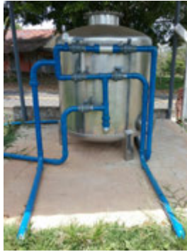
Descrição(4): Filtro compacto metálico de areia e carvão ativado Imagem(5)
