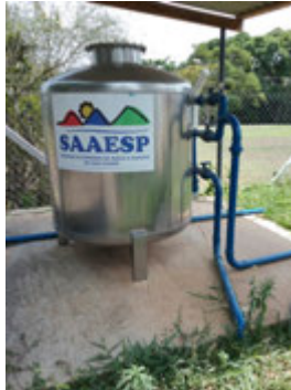
Descrição(4): Filtro compacto metálico de areia e carvão ativado Imagem(5)
