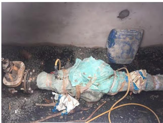
Figura 4 – VRP instalado na derivação entre recalque do Reservatório Residencial Eduardo Abdelnur e Reservatório Cidade Aracy II, e tem como destino bairro Zavaglia
