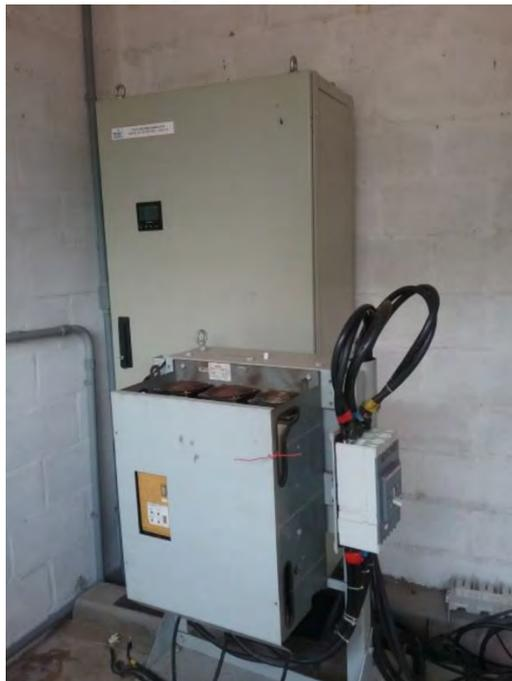
Figura 6 - Improvise para testes das bombas de recalque do Reservatório Residencial Eduardo Abdelnur
