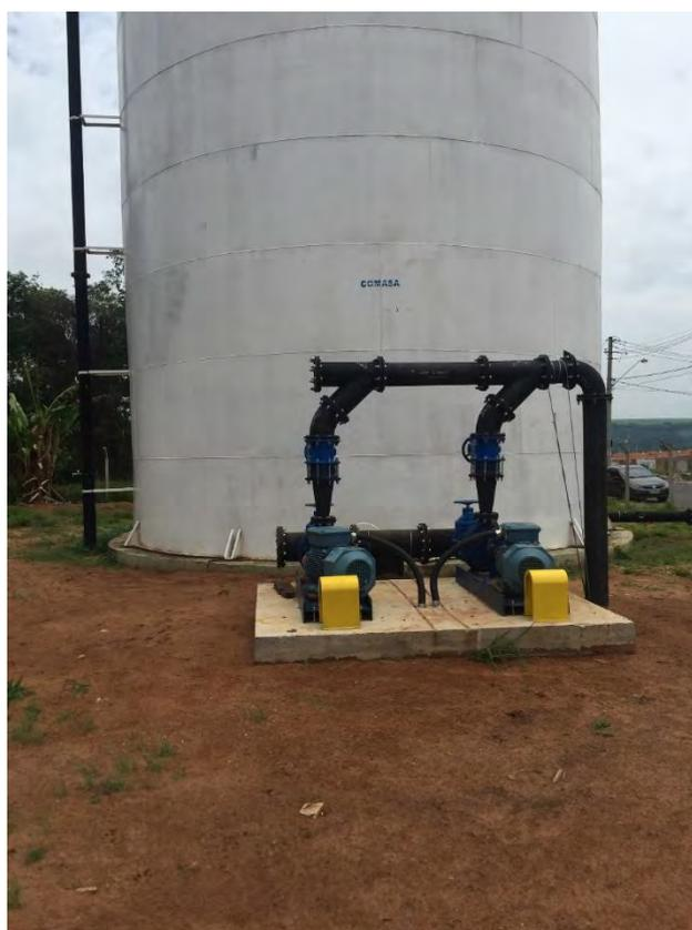
Figura 5- Recalque do Reservatório Residencial Eduardo Abdelnur para Reservatório Cidade Aracy II. As bombas ainda não estão completamente instaladas, mas já estão em fase de teste.
