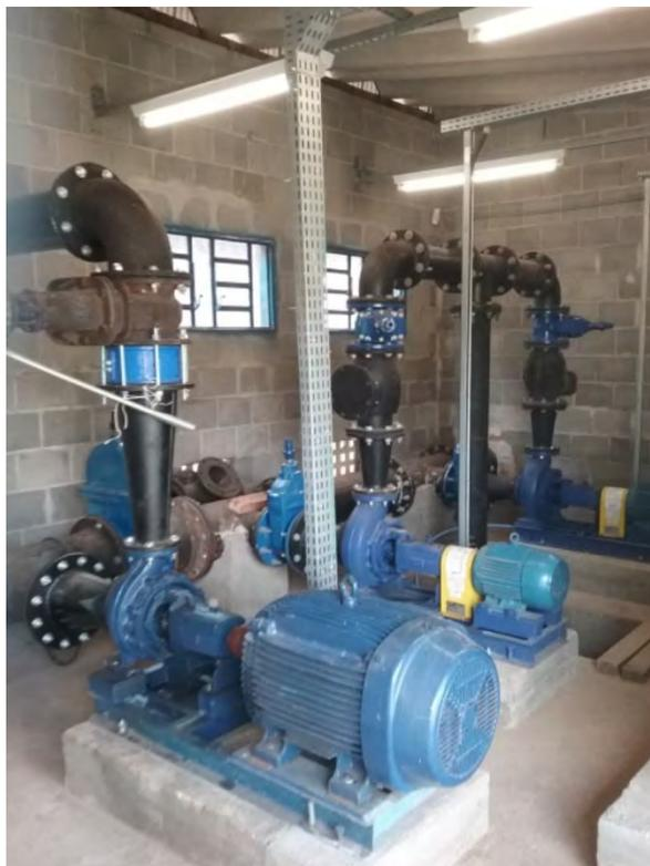
Figura 8 – Casa de bombas Parque Industrial. O conjunto motobomba maior abastece CPRD Nova Estância, os conjuntos menores enviam para o Reservatório elevado do local.
