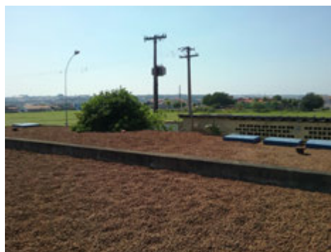
Descrição(6): Cobertura do reservatório e tampas de inspeção
