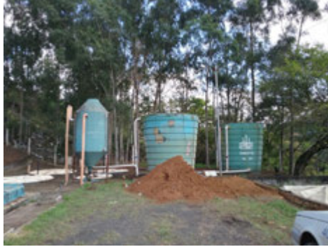
Descrição(2): Sistema de tratamento de lodo desativado
