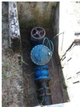
**Descrição(2):** Caixa com registro e válvula de controle de nível com piloto
