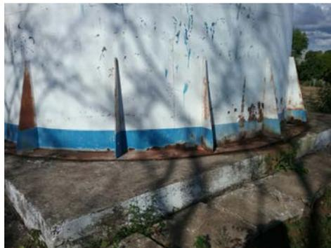
**Descrição(2):** Oxidação em volta da base do reservatório
