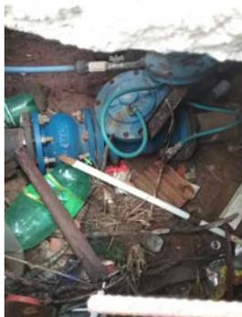
**Descrição(2):** Caixa que abriga a válvula de controle de nível com piloto
