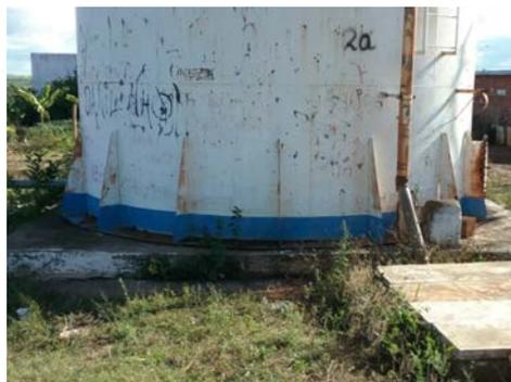
**Descrição(3):** Pontos de oxidação na área em volta da base do reservatório
