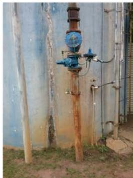
**Descrição(2):** Tubulação de alimentação com válvula controladora de nível
