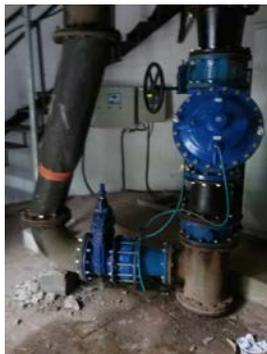
**Descrição(2):** Barrilete de entrada e saída/ Válvula de controle de nível com piloto
