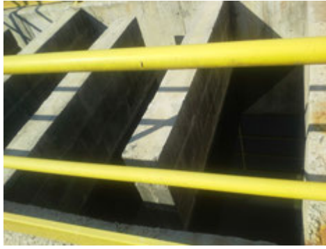
Descrição(8): Chicana de contato aeróbio após o filtro anaeróbio anterior a última fase do filtro de britas aeróbio Imagem(9)
