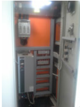
Descrição(12): Painele Elétrico de Comando dos conjuntos motobombas com Inversores de frequência
