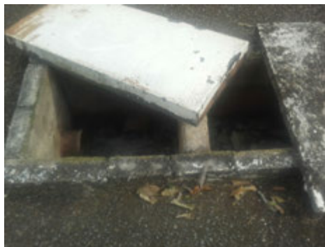
Descrição(3): Caixa de entrada do esgoto bruto
