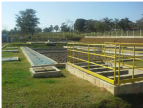
Descrição(10): Vista geral do tanque séptico seguido do filtro anaeróbio e chicana de contato aeróbio Imagem(11)
