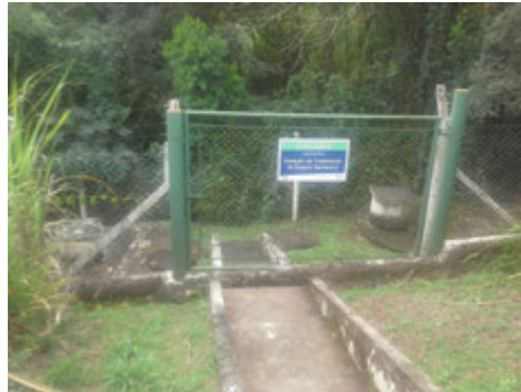
Descrição(3): Fachada da ETE com placa de identificação
