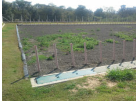
Descrição(9): Detalhe do filtro de britas aeróbio, fase final do tratamento da ETE Anhumas Imagem(10)
