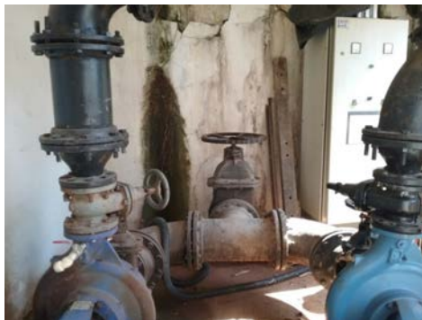
Descrição(3): Detalhe da infiltração na parede da elevatória
