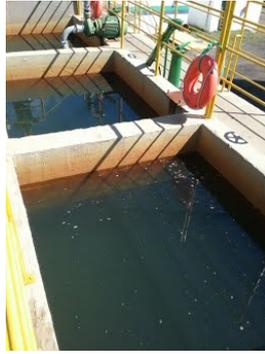
**Descrição(3):** Água a ser filtrada visivelmente suja. Verificar funcionamento dos decantadores, idade e qualidade da camada filtrante, e processo de coagulação.
