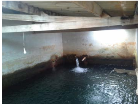
Descrição(5): Detalhe do telhado de cobertura do Reservatório enterrado
