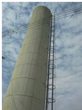
Descrição(7): Escada metálica de acesso à cobertura do Reservatório com guarda - corpos
