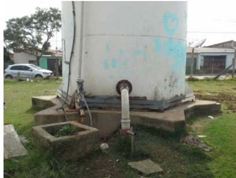
Descrição(4): Caixa de inspeção com registros de manobras das vazões de saída para a distribuição Imagem(5)
