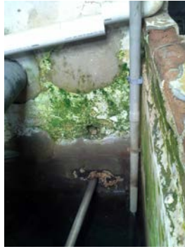
Descrição(4): Detalhe de uma das paredes do Reservatório enterrado
