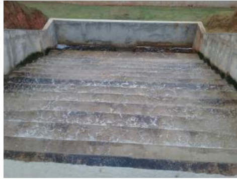
Descrição(17): Escada de aeração do efluente
