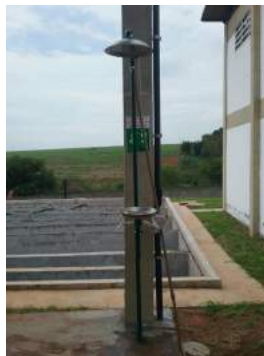
Descrição(10): Tanque de contato sem guarda corpo
