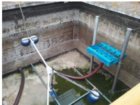
Descrição(6): Reator de lodos ativados em batelada em descanso
