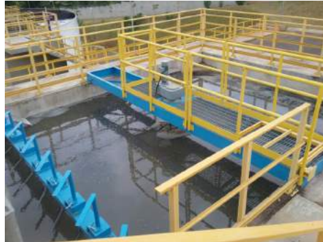
Descrição(5): Calha Parshall de entrada do efluente e medidor ultrassônico Imagem(6)
