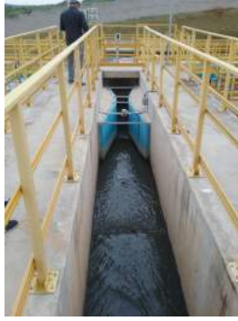
Descrição(5): Calha Parshall de entrada do efluente e medidor ultrassônico Imagem(6)
