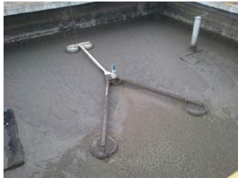
Descrição(6): Reator de lodos ativados em batelada em descanso
