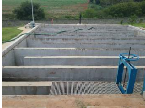
Descrição(10): Tanque de contato sem guarda corpo
