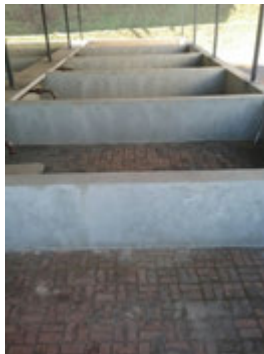
Descrição(9): Leitos de secagem de lodo. Inativos no momento da visita.
