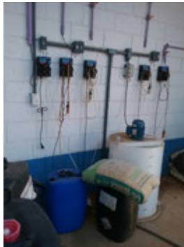
Descrição(8): Futura dosagem de hipoclorito de sódio na desinfecção. Inativa no momento da visita.
