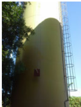
Descrição(11): Detalhe da escada metálica de acesso à cobertura do Reservatório com guarda corpos
