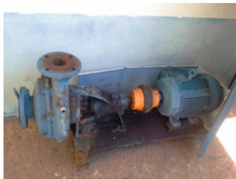
Descrição(7): Conjunto motobomba retirada e substituída no almoxarifado
