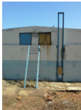
Descrição(6): Detalhes das tampas de inspeções, escada de acesso e medidor de nível
