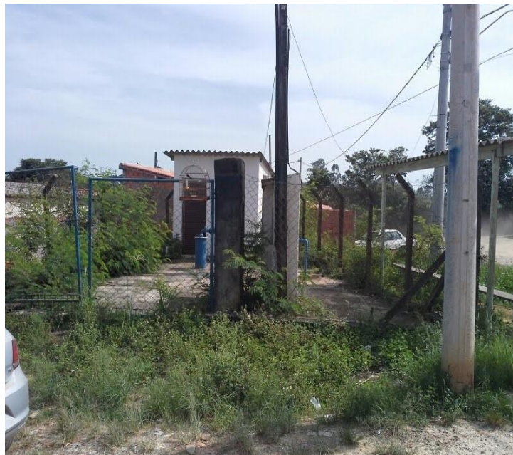
Imagem (1) – Vista geral da área do poço
