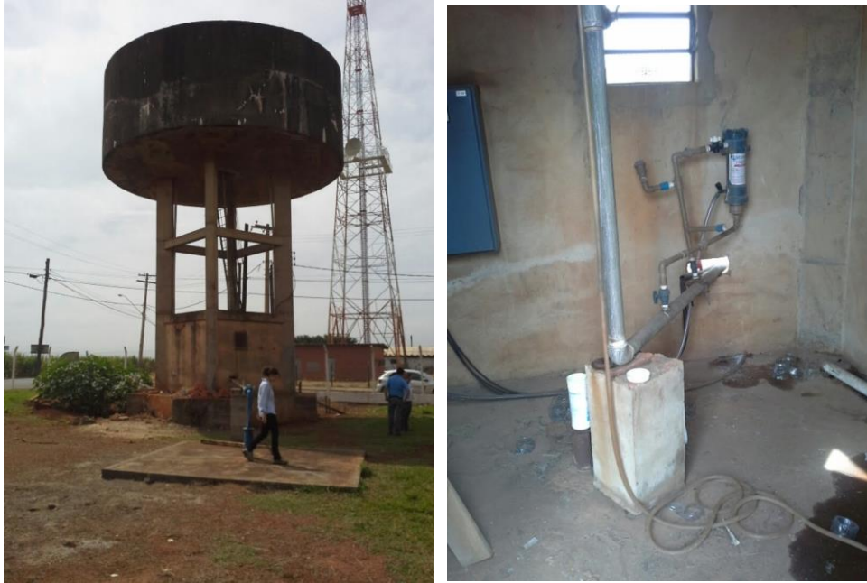
Imagem (2) – Vista geral do reservatório elevado, e Imagem (3) - Tubulação de alimentação com pastilha de cloro e flúor
