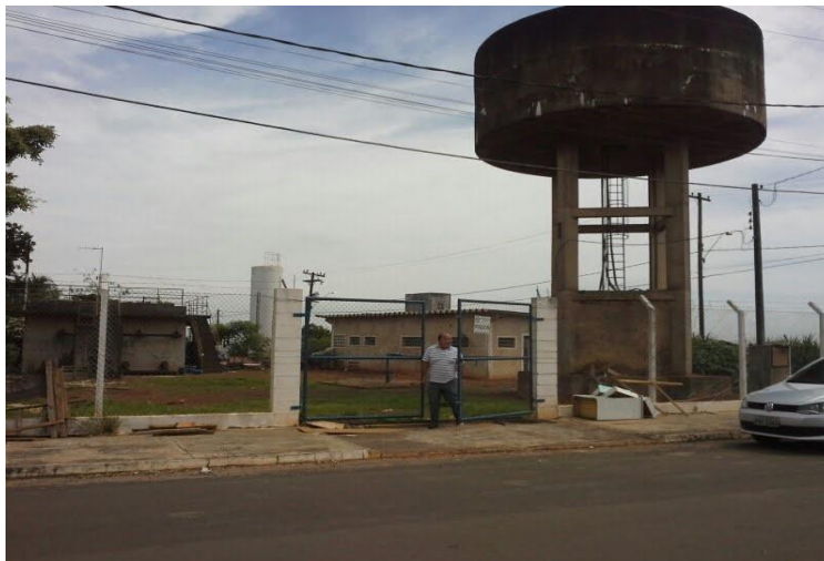
Imagem (1) – Vista geral da área do poço 09 e reservatório
