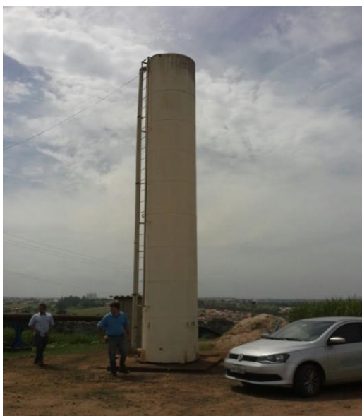
Imagem (1) – Visão geral do reservatório
