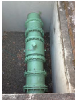
Descrição(8): Macromedidor de entrada do Reservatório Imagem(9)
