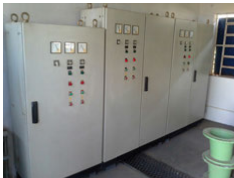
Descrição(5): Painéis de Comando Elétrico dos Conjuntos motobombas
