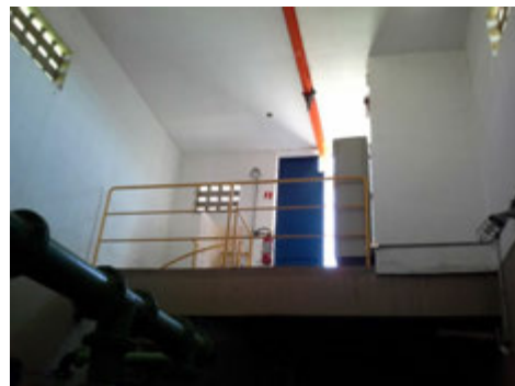
Descrição(11): Detalhes da grade de proteção, do trilho da monovia e patamar superior da casa de bombas com a porta de acesso à mesma
