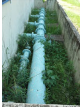
Descrição(3): Detalhe do barrilete de alimentação das EEATs
