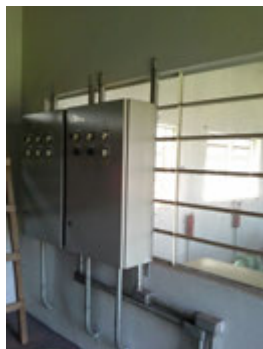
Descrição(5): Painéis de Comando Elétrico dos Conjuntos motobombas
