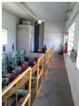
Descrição(10): Outra vista geral da Casa de bombas
