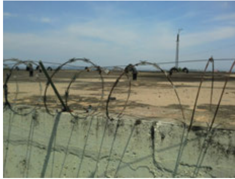
Descrição(8): Vista parcial da cobertura dos Reservatórios
