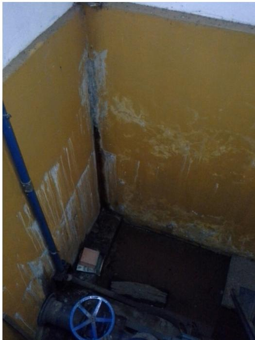
**Informações complementares:** Abastece reservatório elevado e rede simultaneamente. Não há conjuntos de recalque reserva e há vazamento do reservatório apoiado para dentro da EEAT, com acúmulo de água no piso junto das bombas.
