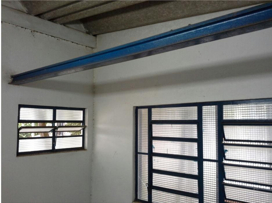
**Descrição(3):** Monovia para retirada de bombas e motores
