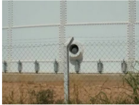
Descrição(4): Orifício de inspeção na base do Reservatório ainda sem a tampa de vedação flangeada Imagem(5)
