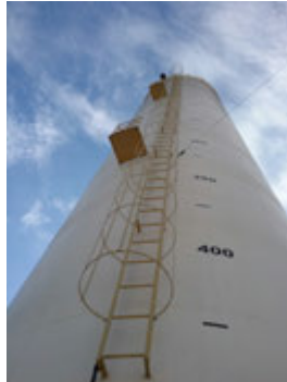
Descrição(5): Escada de acesso à cobertura e marcação dos níveis do antigo medidor Imagem(6)
