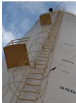
Descrição(5): Escada de acesso à cobertura e marcação dos níveis do antigo medidor Imagem(6)
