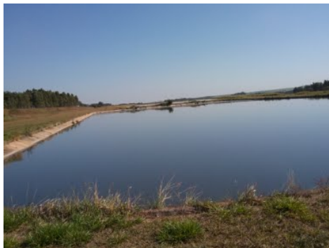
Descrição(6): Vista geral da Lagoa Anaeróbia onde ocorre o início da tratamento com a entrada do esgoto bruto vindo da EEEB - Central, externa à ETE
