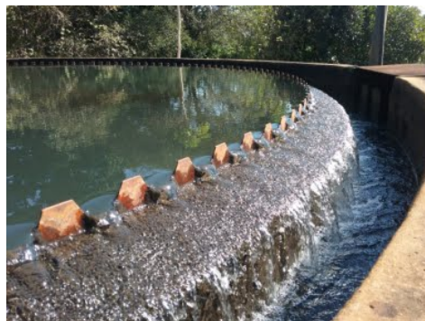
Descrição(18): Outra vista da calha do vertedor do Floculador/Decantador
