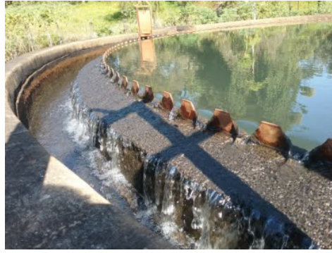
Descrição(15): Detalhe do vertedor do Floculador/Decantador (circular de fluxo ascendente)
