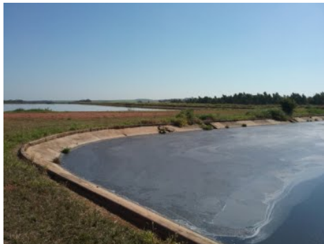
Descrição(5): Detalhe do acúmulo de espuma na superfície da Lagoa Anaeróbia e ao fundo a Lagoa Facultativa na sequência
