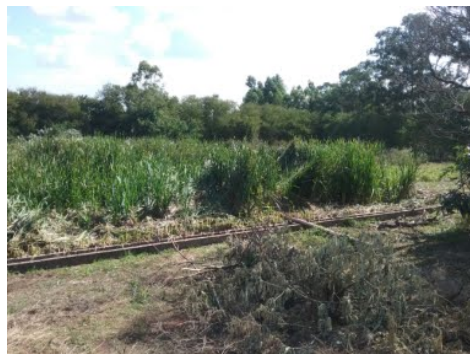
Descrição(4): Canaletas de coleta do esgoto tratado, que passou pelos módulos com vegetação (taboa) Imagem(5)
