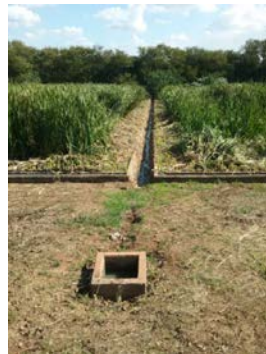
Descrição(4): Canaletas de coleta do esgoto tratado, que passou pelos módulos com vegetação (taboa) Imagem(5)
