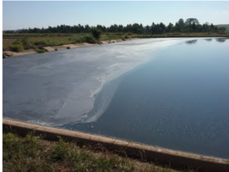
Descrição(4): Detalhe da superfície da Lagoa Anaeróbia no ponto de transição para a sequência do tratamento na próxima Lagoa, a Facultativa
