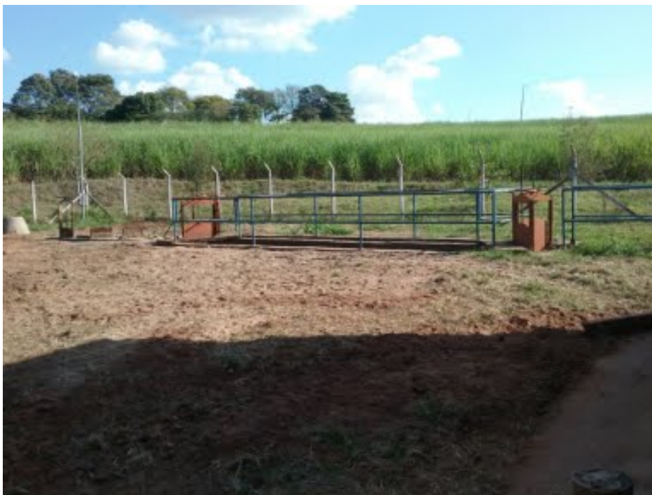
Descrição(9): Vista geral do tratamento preliminar
