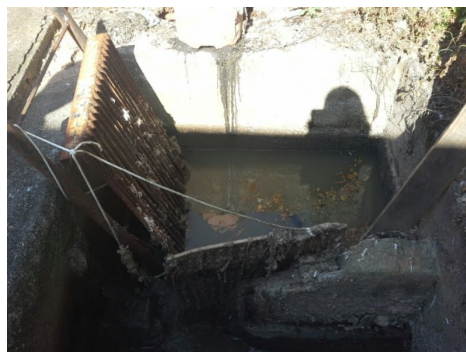
Descrição (5): Detalhe ausência de drenagem gaxeta
