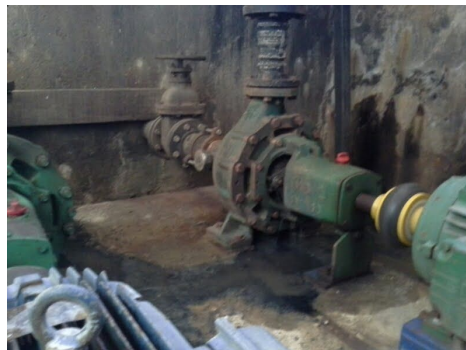
Descrição (5): Detalhe ausência de drenagem gaxeta
