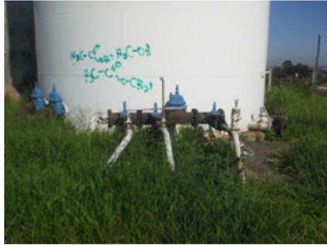
**Descrição(4):** Barriletes com as tubulações de recalque de 03 ( três ) poços tubulares profundos que com registros de alimentação do Reservatório
