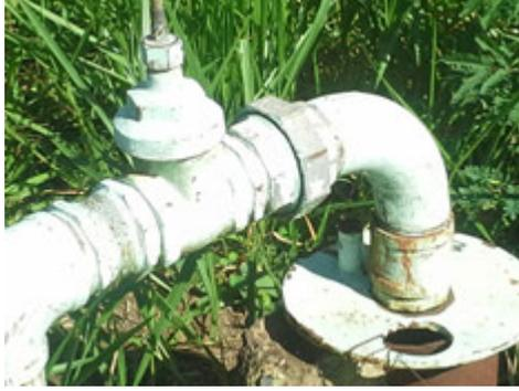
**Descrição(5):** Nesta vista detalhada mostra o tubo medidor de nível na boca do poço tubular profundo
