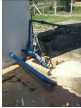
**Descrição(4):** Chegada do poço distante com sistema de cloração e flúoretação com pastilhas e tubulação de saída de uma das distribuições
