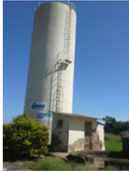
**Descrição(4):** Vista geral do Reservatório e da casa de química e dosadores de cloro e flúor na água do poço local Sgaribold que alimenta o Reservatório junto com mais 4 (quatro) poços externos.
