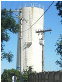
**Descrição(2):** Vista do Reservatório com detalhes da escada de acesso à cobertura e as grades guarda corpos.
