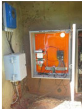
**Descrição(2):** Painel Elétrico de transmissão de dados de vazões por telemetria e Amostrador de vazões no local
