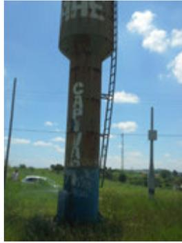
**Descrição(4):** Vista geral e o detalhe da escada metálica sem guarda corpos e local sem o devido isolamento com um cercado
