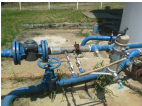
**Descrição(3):** Barrilete de recalque com medidor de vazões, registros, estação dosadora de cloro e de flúor de pastilhas
