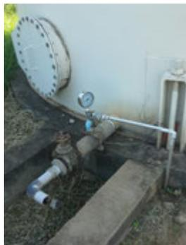
**Descrição(11):** Tampa de inspeção de fundo e manômetro de pressão que funciona como medidor do nível de água no Reservatório
