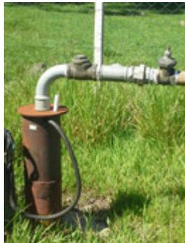
**Descrição(2):** Poço tubular profundo com cavalete de recalque, válvula de retenção, registro e tubo medidor de nível na boca do poço
