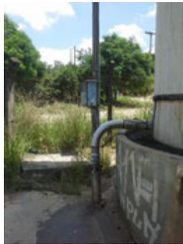
**Descrição(5):** Detalhe da tubulação de alimentação da EEAT local que recalca água tratada para o Reservatório Elevado Santa Rita
