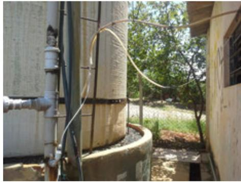
**Descrição(4):** Detalhe da tubulação com a inserção de dosadores de cloro e flúor e da base do Reservatório
