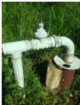
**Descrição(4):** Detalhe do cavelete de recalque e da boca do poço tubular profundo, faltando muitos quesitos de equipamentos exigíveis pela Portaria DAEE de Outorgas
