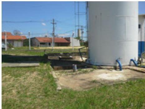
**Descrição(2):** Base do Reservatório com as tubulações das duas saídas de água tratada para a rede de distribuição
