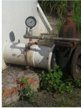
**Descrição(8):** Ponto de derivação da água do reservatório com manômetro de pressão na rede
