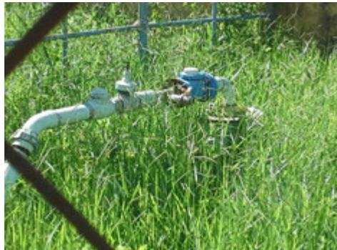
**Descrição(2):** Cavalete de recalque na saída do poço tubular profundo com hidrômetro, válvula de retenção e registro
