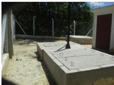
**Descrição:** Detalhes da caixa de inspeção do barrilete da tubulação de recalque com válvula e registros de manobras das vazões de saída do esgoto bruto para a ETE Castelani e vista geral do restante do sistema da EEE
