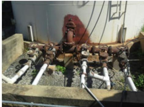
**Descrição(9):** Barrilete da tubulação de alimentação dos 5 (cinco) poços ao Reservatório e da tubulação de saída do Reservatório e alimentação da rede pública de distribuição
