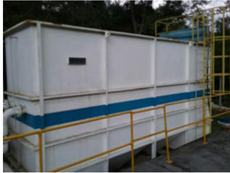
**Descrição(2):** ETA compacta (floculador, decantador e filtros)
