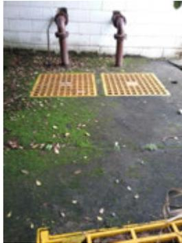
**Descrição:** Gradeamento grosseiro e poço de sucção
