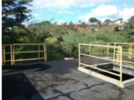
**Descrição(4):** Ausência de guarda corpo no tanque de aeração
