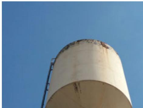
**Descrição(2):** Sinais de oxidação e umidade na borda superior do reservatório
