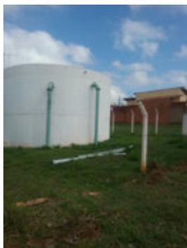
**Item 6.4:** Existência de locais sem guarda-corpos ou escadas em situação inadequada (Art. 5.16 da NBR 12217/1994). Prazo: Em até 180 dias
