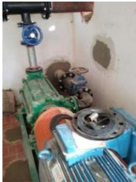
**Descrição(2):** Nova bomba da elevatória (60 m3/h)
