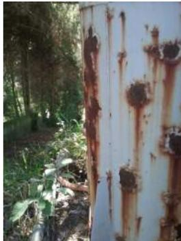
**Descrição(2):** Detalhe de pontos de ferrugem no reservatório
