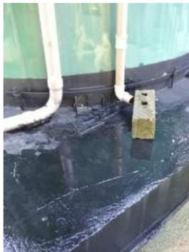
**Descrição(2):** Detalhe de extravasamento de água do extravasor
