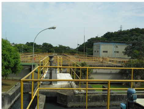
Vista Geral dos Reatores da ETE Pinheirinho.
