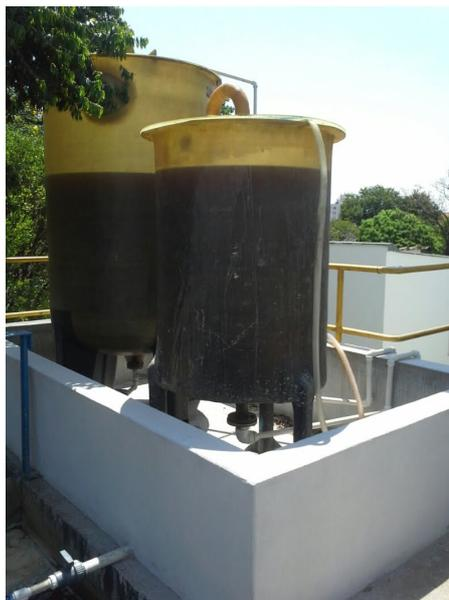
**Instalação de contenção em tanques de produtos químicos**
