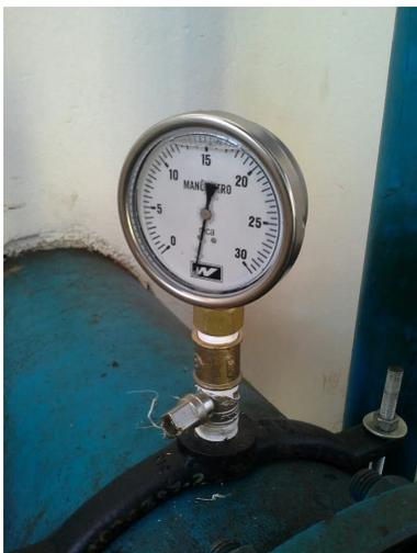
Instalação de manômetro na bomba da elevatória
