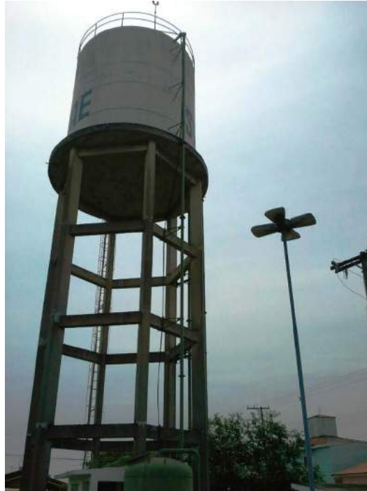
Descrição(2): Reservatório 05 do Sistema Altos do Tietê.
