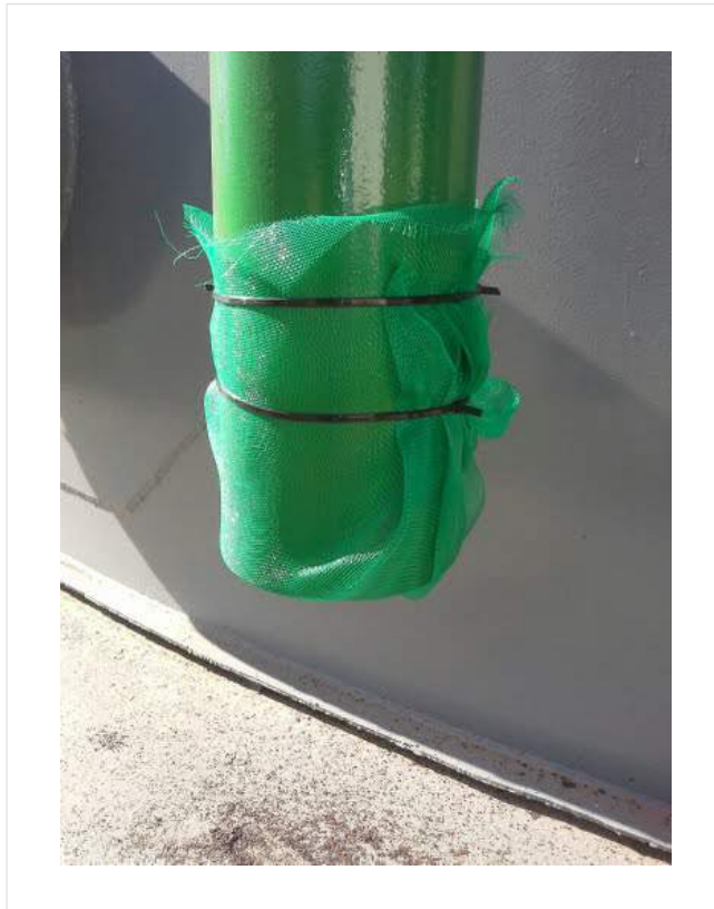
Descrição(2): Proteção da tubulação de extravazão
