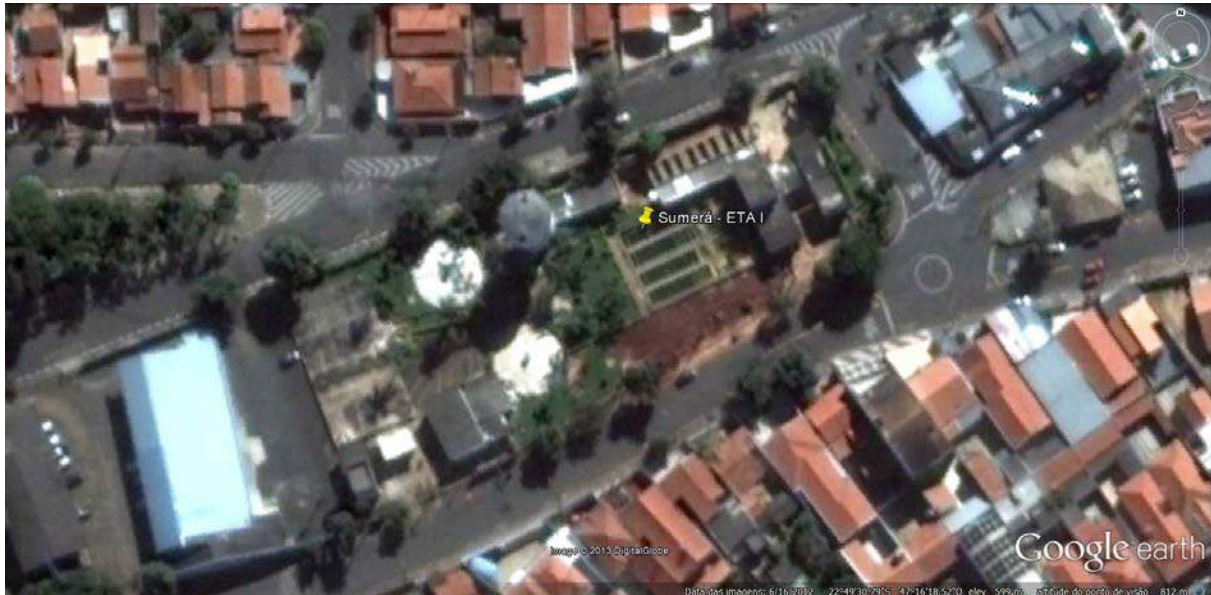
Figura 7 - Imagem de satélite da Estação de Tratamento de Água – ETA I
