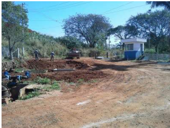
Descrição(3): Reforma da portaria e acesso a área da captação
