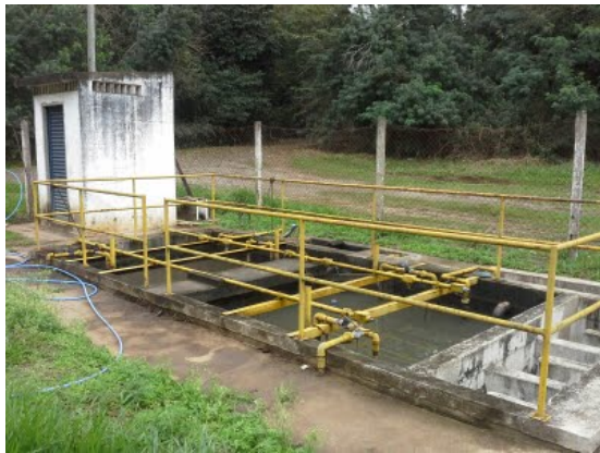
Descrição(8): ETE e casa de sopradores ao fundo
