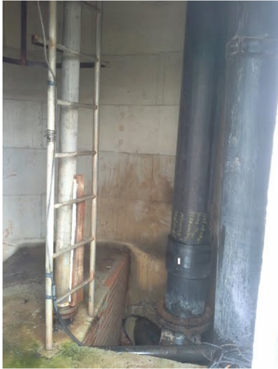
Descrição(2): Tubulações e escada de acesso
