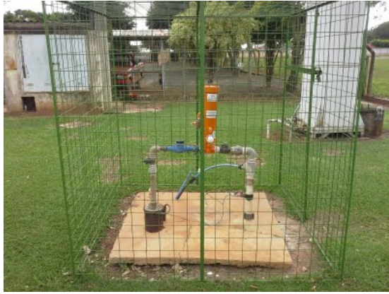
Descrição(1): Aspecto geral do poço
