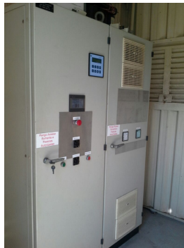
Descrição(9): Painéis de Comando Elétrico dos Conjuntos motobombas
