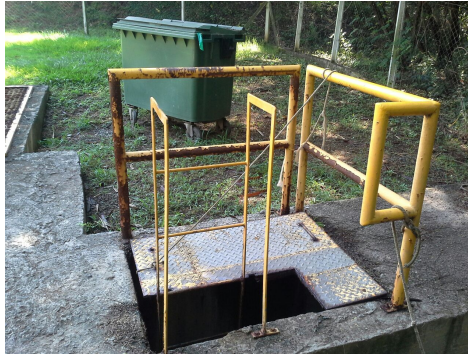
Descrição(8): Poço de entrada do esgoto bruto com escada marnheiro metálica
