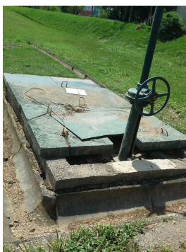
Descrição: Caixa de entrada de esgoto bruto com registro de comporta Imagens(5)
