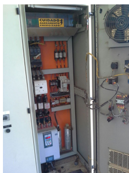
Descrição: Vista do interior do Painel Elétrico com soft starter Imagens(9)
