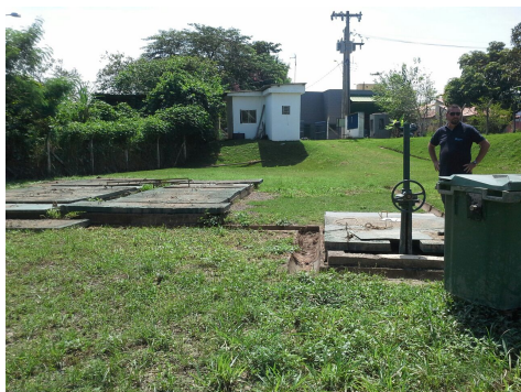
Descrição: Vista geral da EEE- Final com todos os poços de entrada com registro de comporta, Poço de sucção e ao fundo a edificação que abriga o painel de comando elétrico dos conjuntos motobombas Imagens(4)
