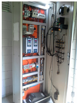
Descrição: Vista do interior do Painel Elétrico com soft starter Imagens(8)
