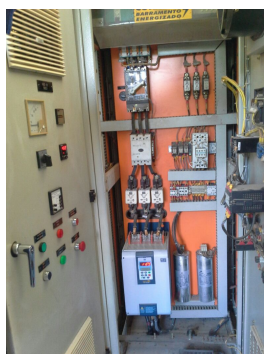
Descrição: Vista do interior do Painel Elétrico com soft starter Imagens(9)
