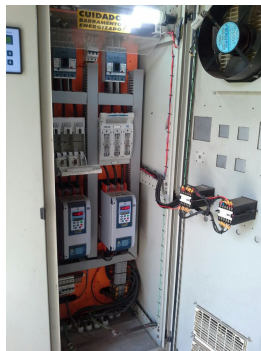
Descrição(10): Vista do interior do Painele Elétrico com soft starter
