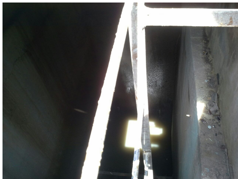
Descrição: Caixa de entrada de esgoto bruto com escada marnheiro de acesso Imagens(3)
