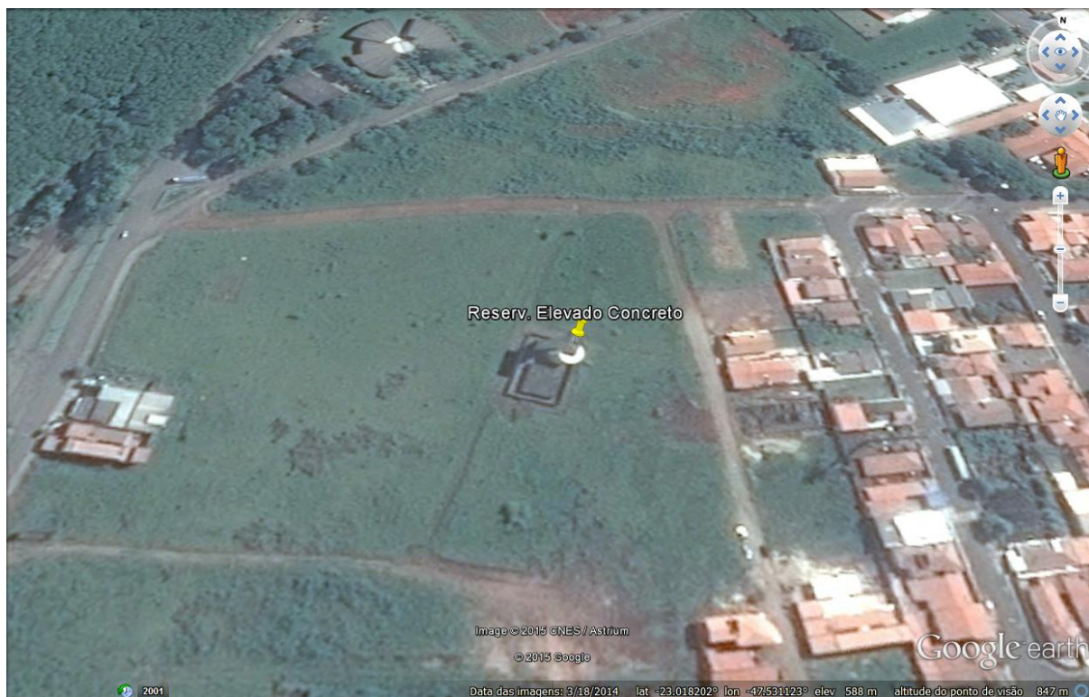
Figura 9 – Imagem do Reservatório Elevado em Concreto - EEAT – Recalque 03.
