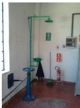
Instalação de chuveiro de emergência no laboratório.
