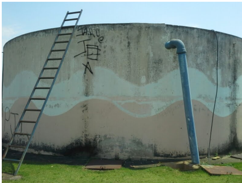
Vista Geral do Reservatório Apoiado do Jardim Andrade.
