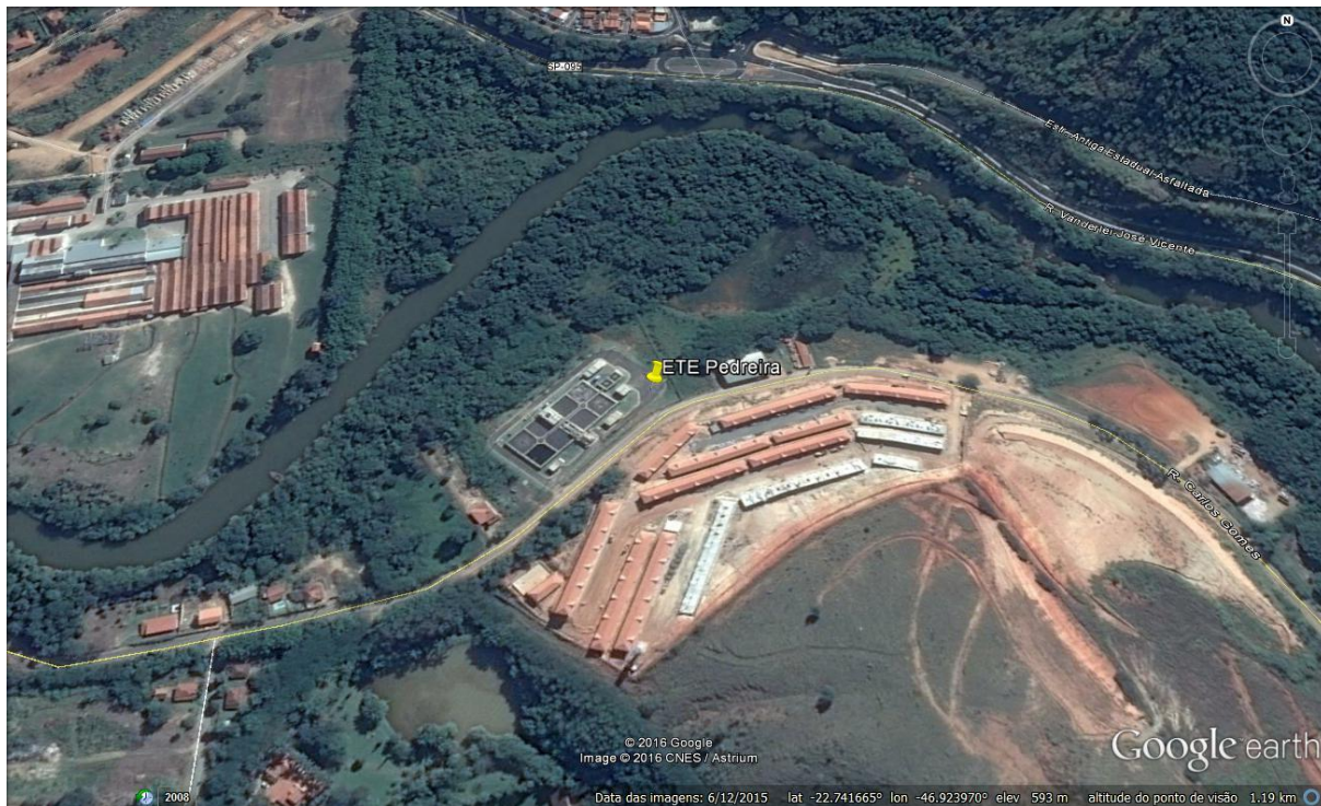
Figura 21 – Imagem de satélite da Estação de Tratamento de Esgoto de Pedreira
