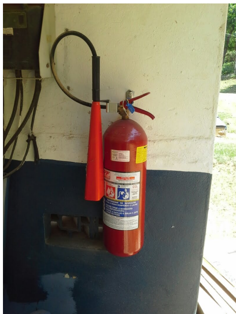
Instalação do extintor de incêndio
