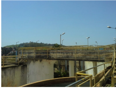
Vista Geral do guarda corpo da ETA
