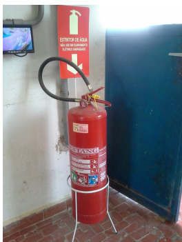
Instalação de extintor de incêndio
