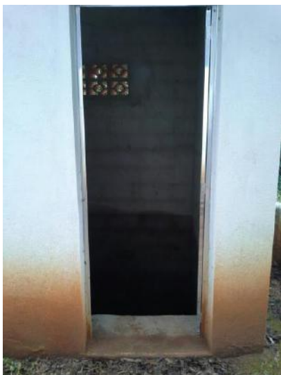
Aspecto externo da elevatória
