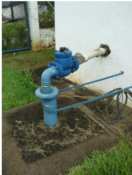
Aspecto geral do poço
