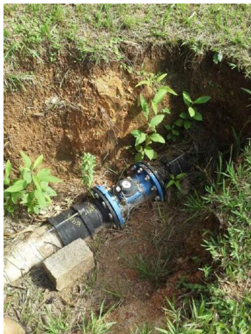
Instalação de macromedidor na ETA
