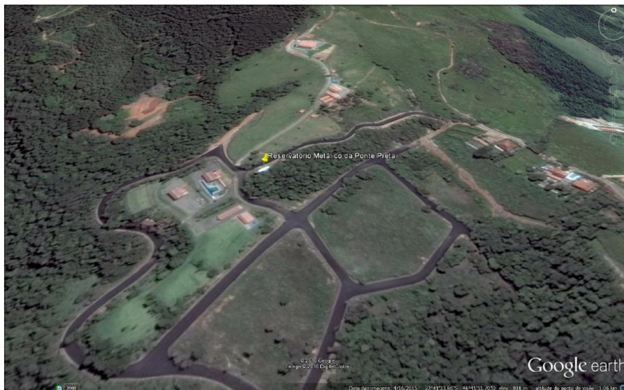
Figura 21 – Imagem de satélite do reservatório metálico da Ponte Preta
