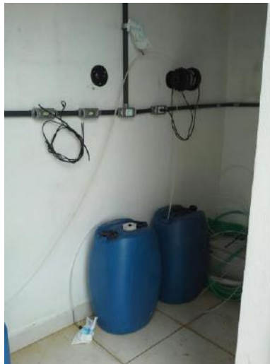
Casa de armazenamento de cloro e flúor
