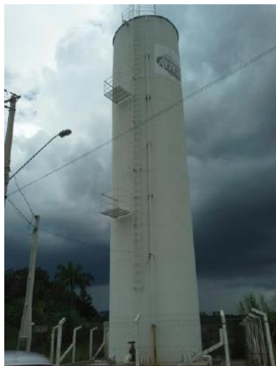
Aspecto geral do reservatório
