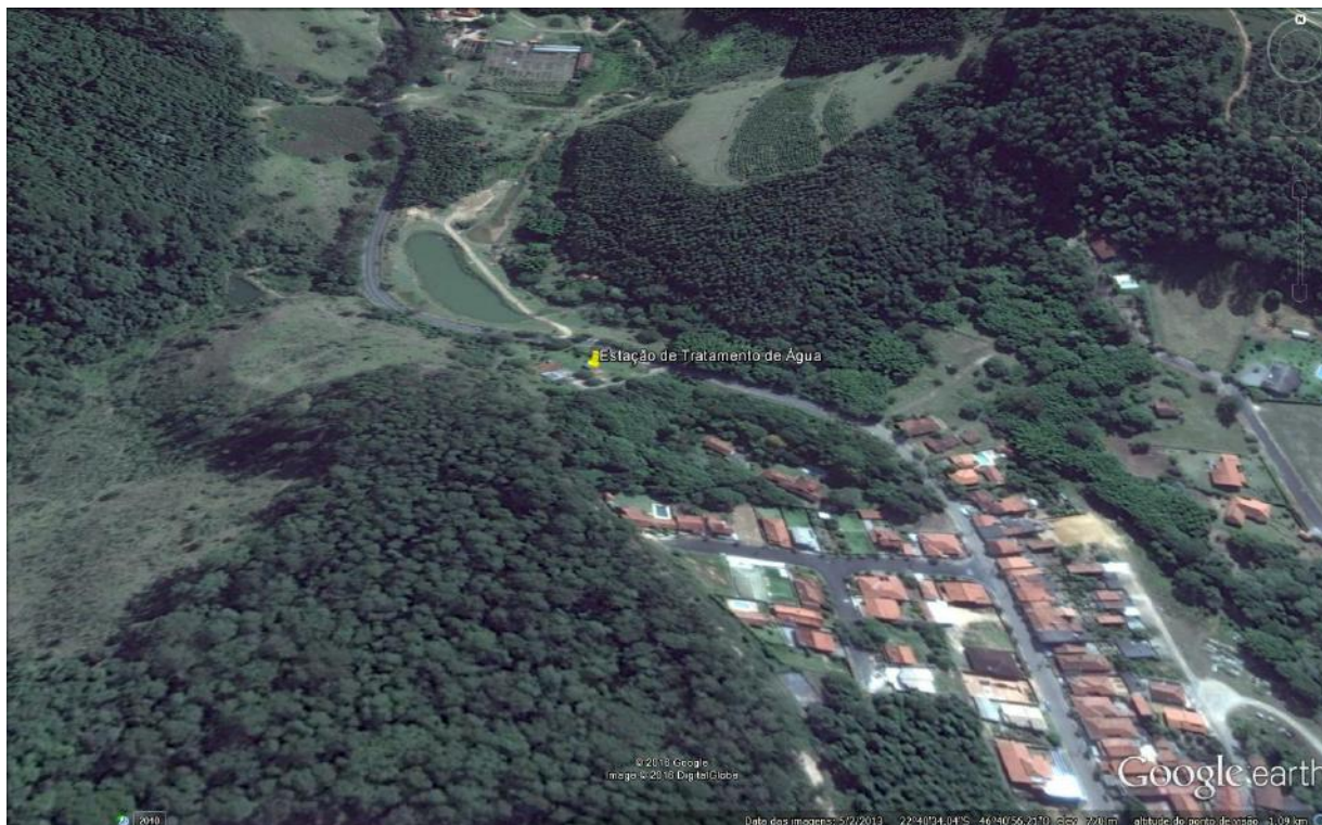
Figura 10 – Imagem de satélite da estação de tratamento de água
