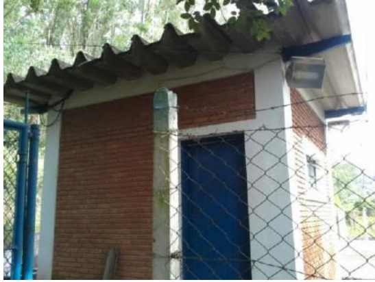
Aspecto externo da elevatória
