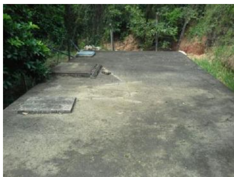
Aspecto geral do reservatório
