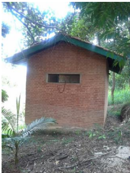
Aspecto externo da elevatória
