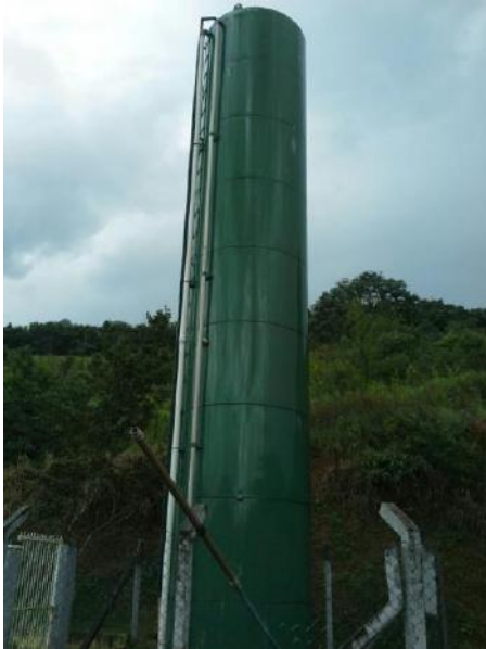
Aspecto geral do reservatório
