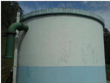
Aspecto geral do reservatório
