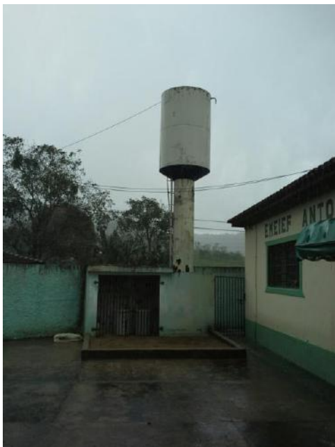
Aspecto geral do reservatório
