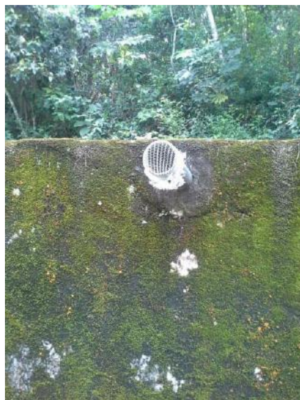
Instalação de tubulação de ventilação
