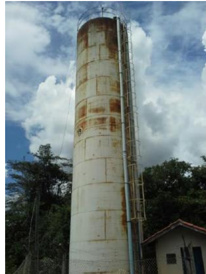
Aspecto geral do reservatório
