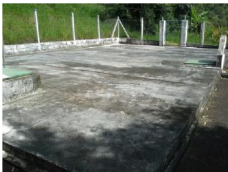
Aspecto geral do reservatório
