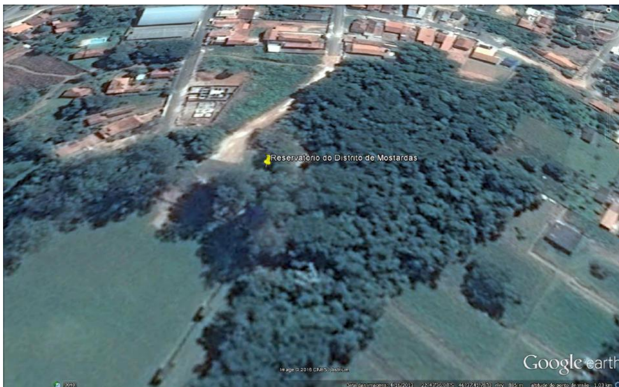
Figura 14 – Imagem de satélite do reservatório do Distrito das Mostardas
