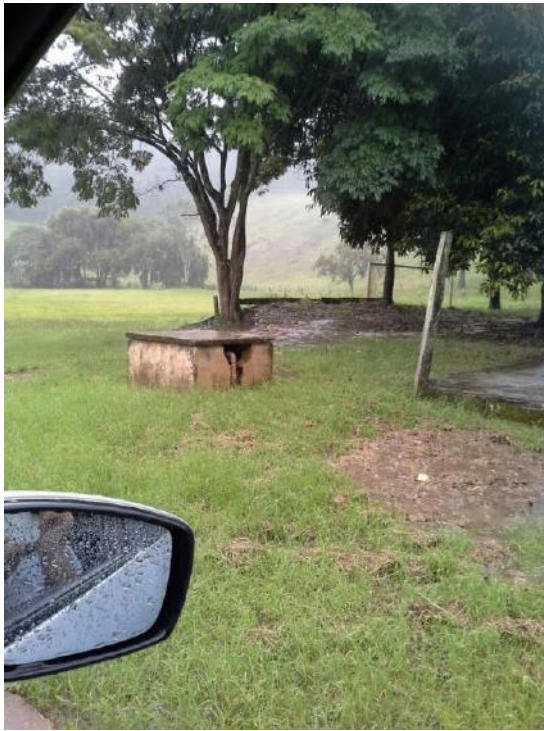
Aspecto geral do poço
