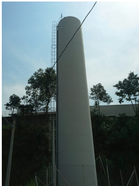
Aspecto geral do reservatório Quinta das Videiras
