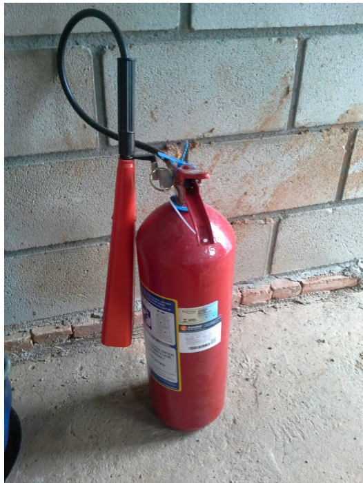
Instalação do extintor de incêndio
