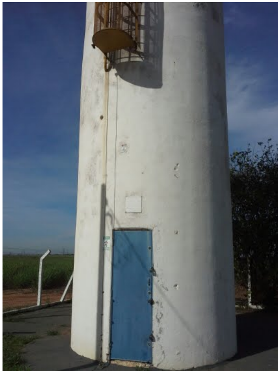
Descrição(3): Acesso à escada, com porta e cadeado
