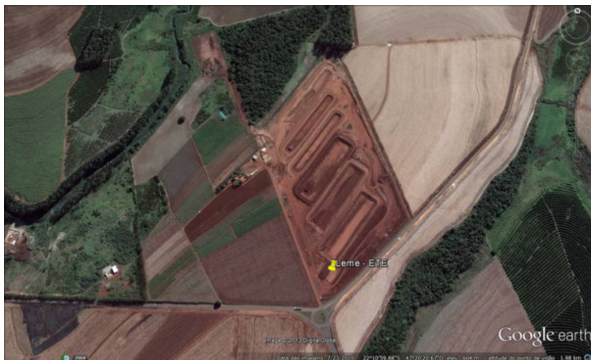
Figura 6 - Imagem de satélite da ETE
