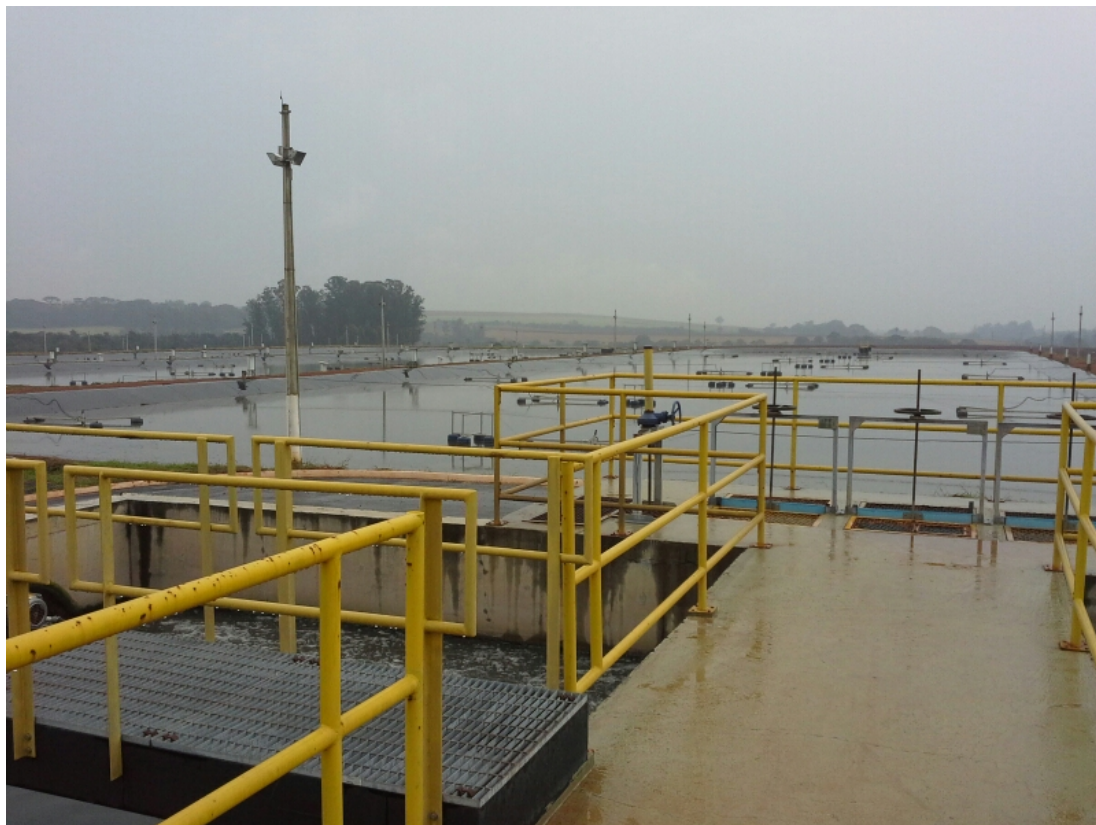
Descrição(4): Aspecto geral da ETE
