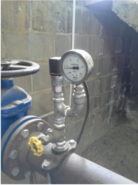
Instalação de Manômetro no Conjunto de Recalque.
