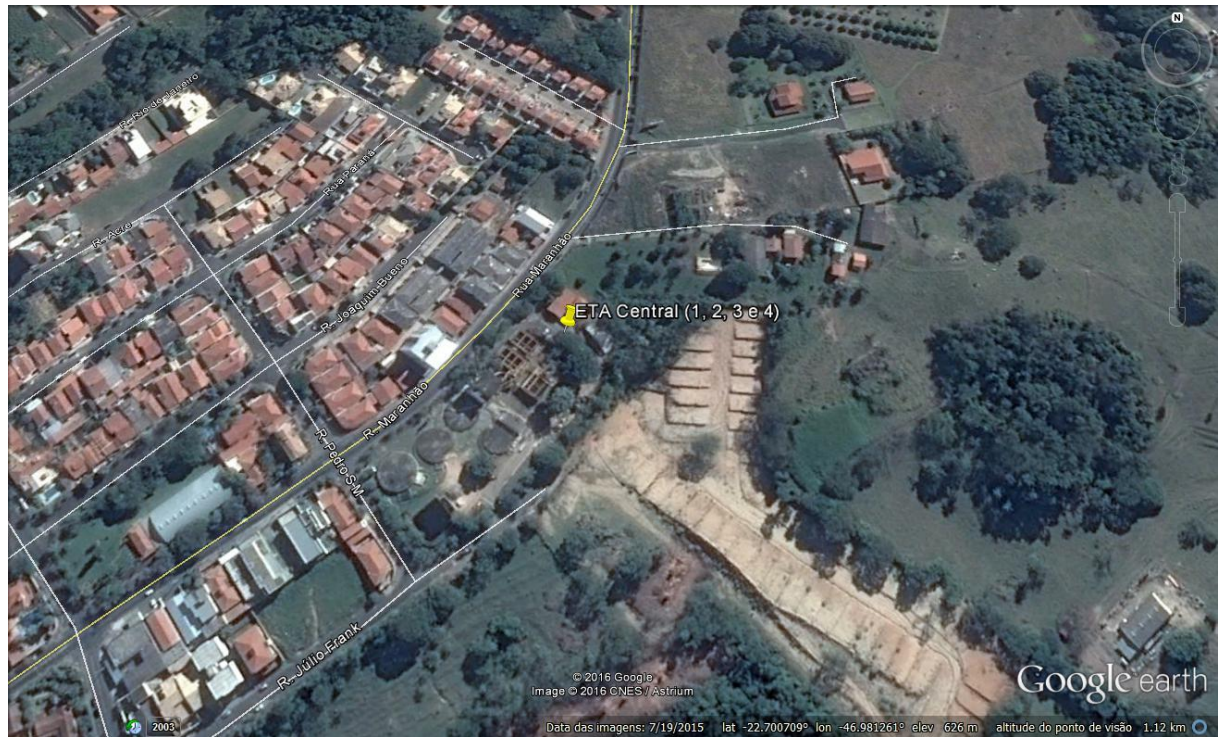
Figura 9 – Imagem de satélite das Estações de Tratamento de Água – ETA 4 (Central)
