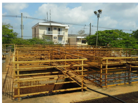
Vista Geral das ETA 2.
