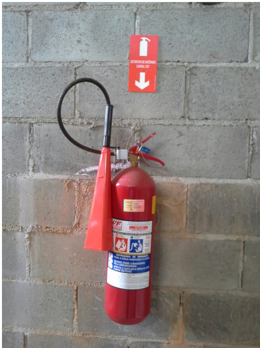
Instalação de Extintor de Incêndio na Estação Elevatória de Água Cruzeiro.
