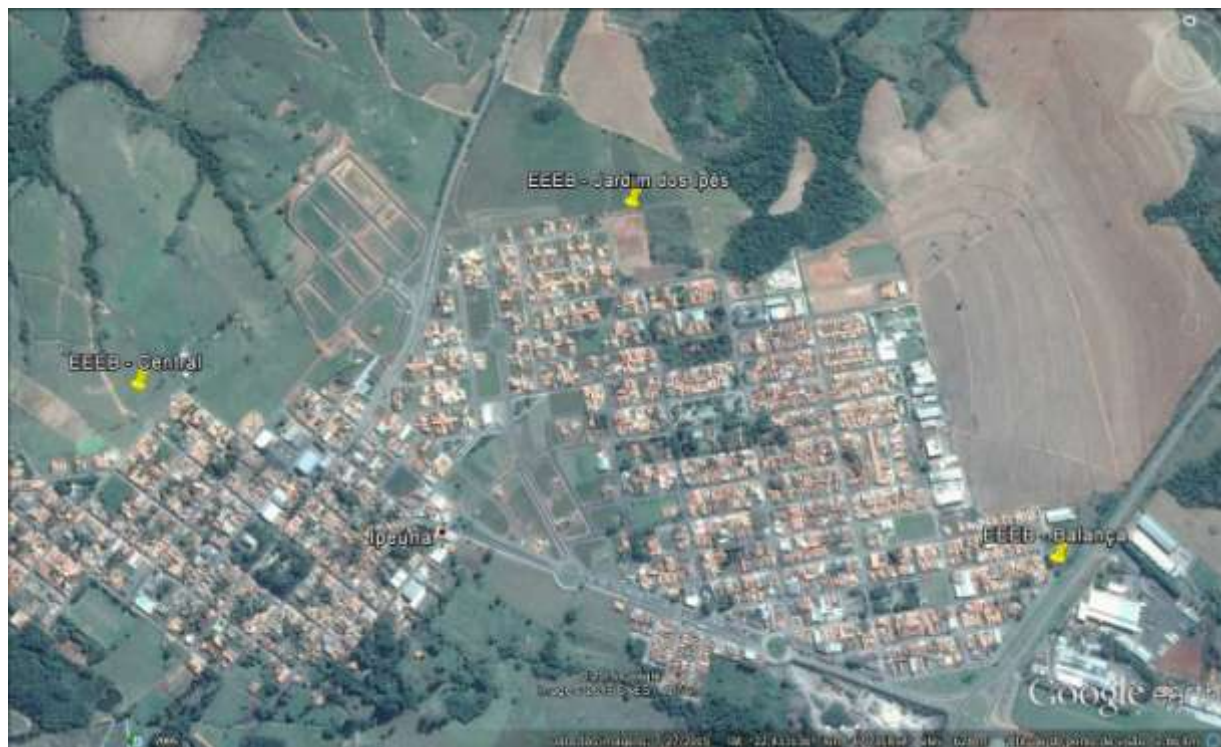
Figura 9 - Subsistemas SES Fiscalizados em 24/08/2015.
