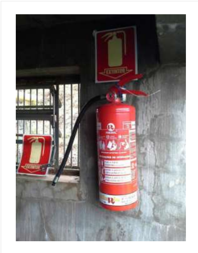
Descrição(3): Instalado extintor de incêndio na casa de bombas
