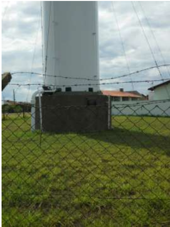
Descrição(2): Reservatorio recentemente realizada manutenção e pintura
