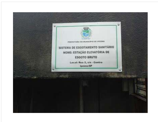
Descrição(5): Placa de identificação da EEEB
