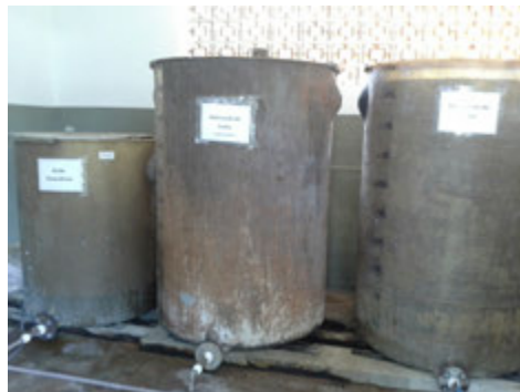
Descrição(6): Mistura de hipoclorito de sódio e ácido florsilicico
