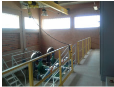
Descrição(8): Outra vista geral da casa de bombas
