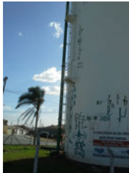
Descrição(5): Escada metálica de acesso à cobertura e tubulação de alimentação
