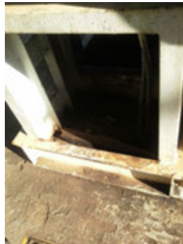
Descrição(3): Entrada de esgoto bruto com gradeamento grosseiro
