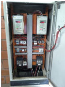
Descrição(5): Painel Elétrico de Comando dos conjuntos motobombas com soft starter
