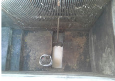
Descrição(3): Entrada de esgoto bruto com gradeamento grosseiro
