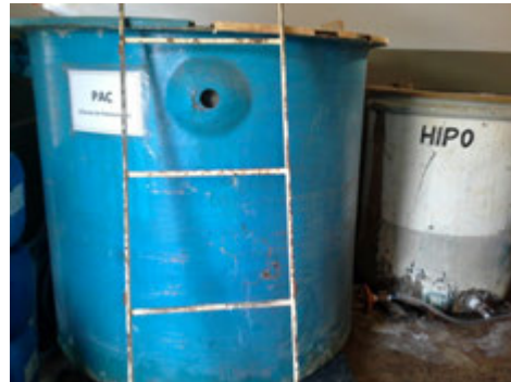
Descrição(4): Sala de química com os dosadores de cloro
