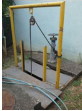
Descrição(4): Sistema de de gradeamento grosseiro e registro comporta de entrada de esgoto bruto Imagem(5)
