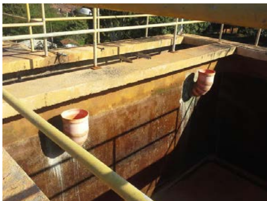
Descrição(4): Mudança tubulação saída decantador
