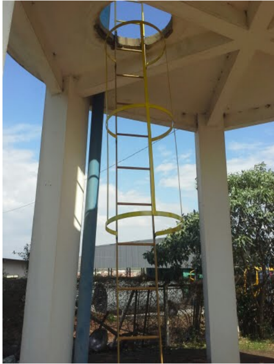
Descrição(2): Detalhe guarda corpo instalado
