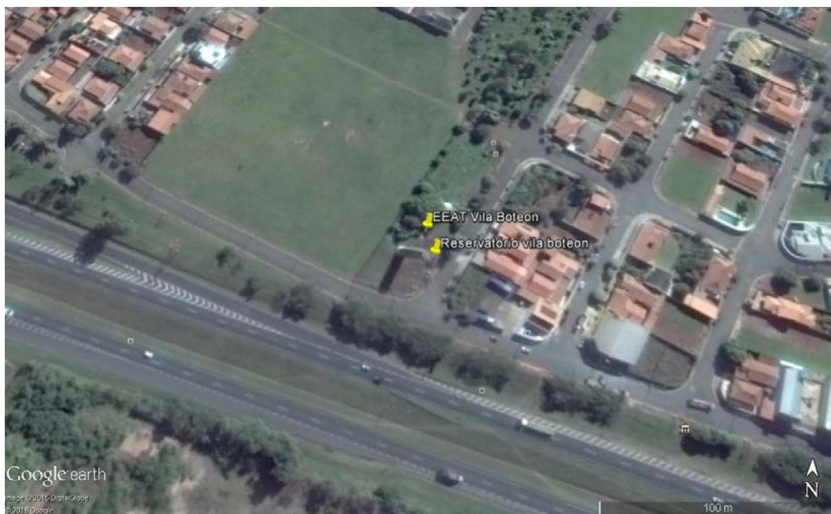
Figura 6: Imagem de satélite do reservatório e EEAT Vila Boteon
