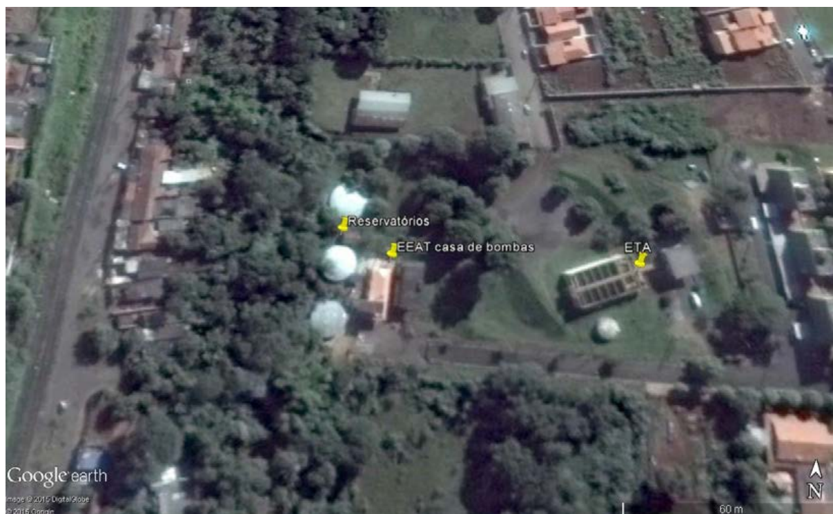
Figura 4: Imagem de satélite da ETA, EEAT casa de bombas e reservatórios semi enterrados
