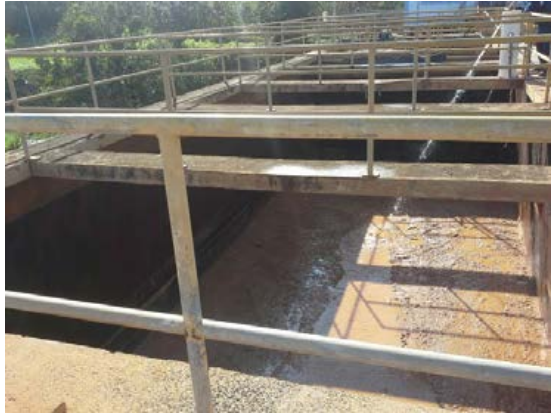
Descrição(5): Limpeza do decantador
