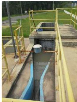
**Descrição(1):** Chegada do esgoto bruto no tratamento preliminar com gradeamento grosseiro, desarenadores e medidor de vazão ultrassônico na calha Parshall.
