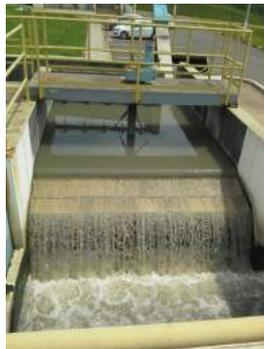
**Descrição(2):** Saída do esgoto bruto do desarenador para os tanques de aeração prolongada dos lodos ativados.
