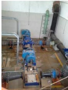
**Descrição(1):** Conjuntos moto-bombas da EEAB para o recalque às ETA1 e ETA2.
