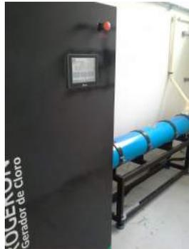
**Descrição(8):** Gerador de Solução de Hipoclorito de sódio. O sistema utiliza somente água, energia elétrica e sal (cloreto de sódio) para a produção da solução oxidante.
