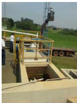
**Descrição(1):** Chegada da água bruta com calha Parshall e medidor de vazão ultrassônico e pontos de pré cloração e aplicação de floculante.
