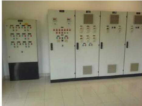
**Descrição(4):** Painéis elétricos de comandos dos conjuntos moto-bombas e de abertura e fechamento de válvulas e registros de manobras operacionais do processo de tratamento.
