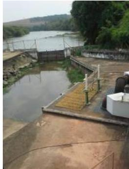
**Descrição(5):** Tomada de água, canal de adução com grades e comportas, e poço de sucção aspirada dos conjuntos moto-bombas da EEAB da captação superficial do Rio Sorocaba.
