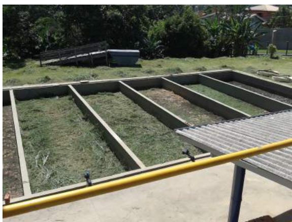
Leitos de Secagem do Lodo (fora de funcionamento na data da inspeção).
