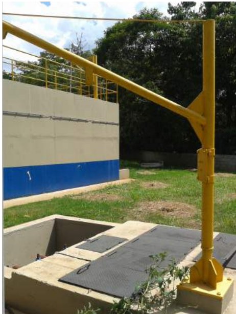
Elevatória de Esgoto da ETE Terras do Barão.
