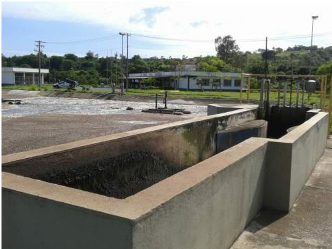
Entrada do Esgoto no Tanque de Aeração.
