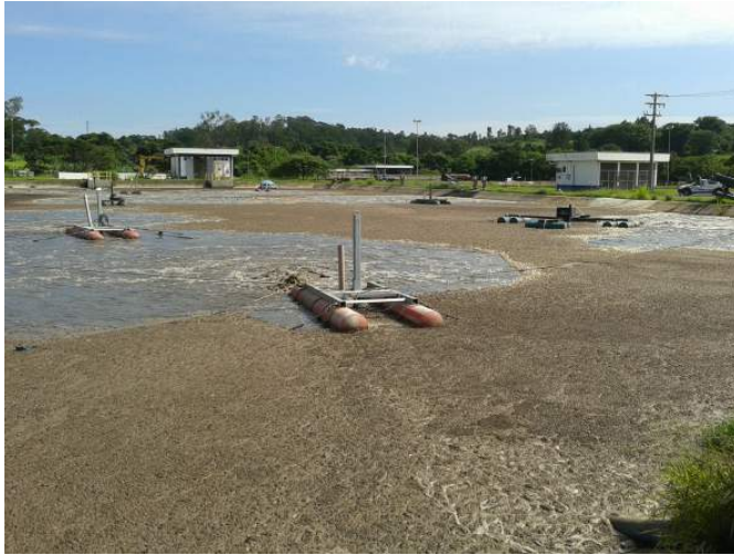
Vista do Processo de Lodos Ativados com Aeradores em Operação.
