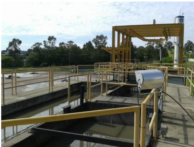
Gradeamento para Retirada de Sólidos do Esgoto.
