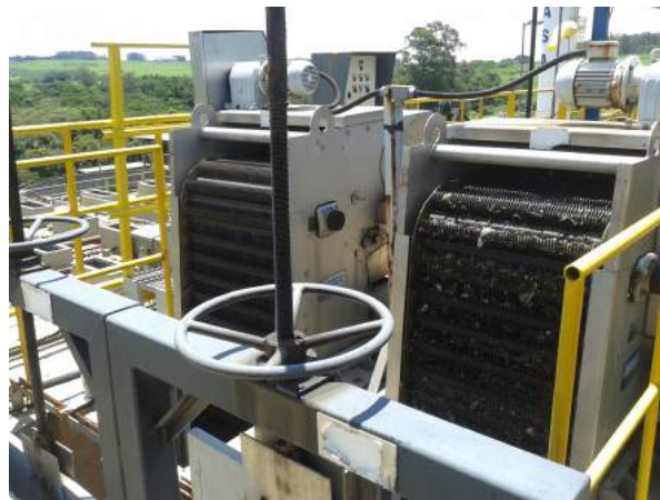
Dispositivos de Retirada de Sólidos Grosseiros e Finos.
