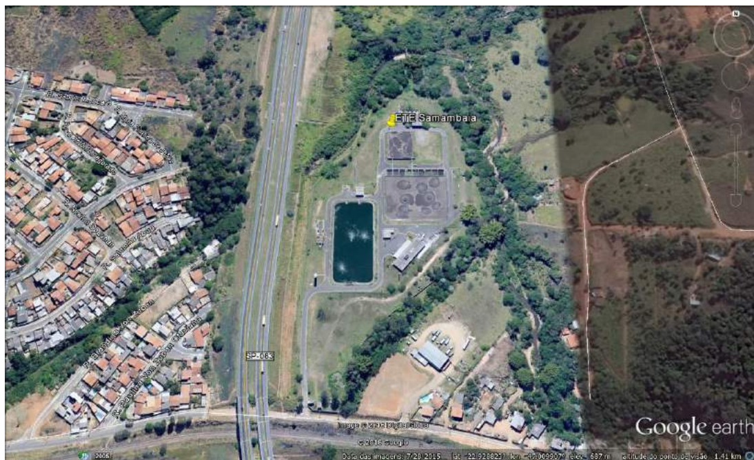
Figura 2 - Imagem de satélite da ETE Samambaia
