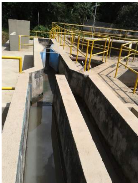
Passagem do Esgoto pelas Caixas de Areia.
