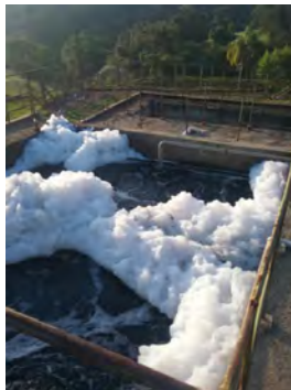
Descrição(5): Detalhe para a formação de espuma no Lodos Ativados
