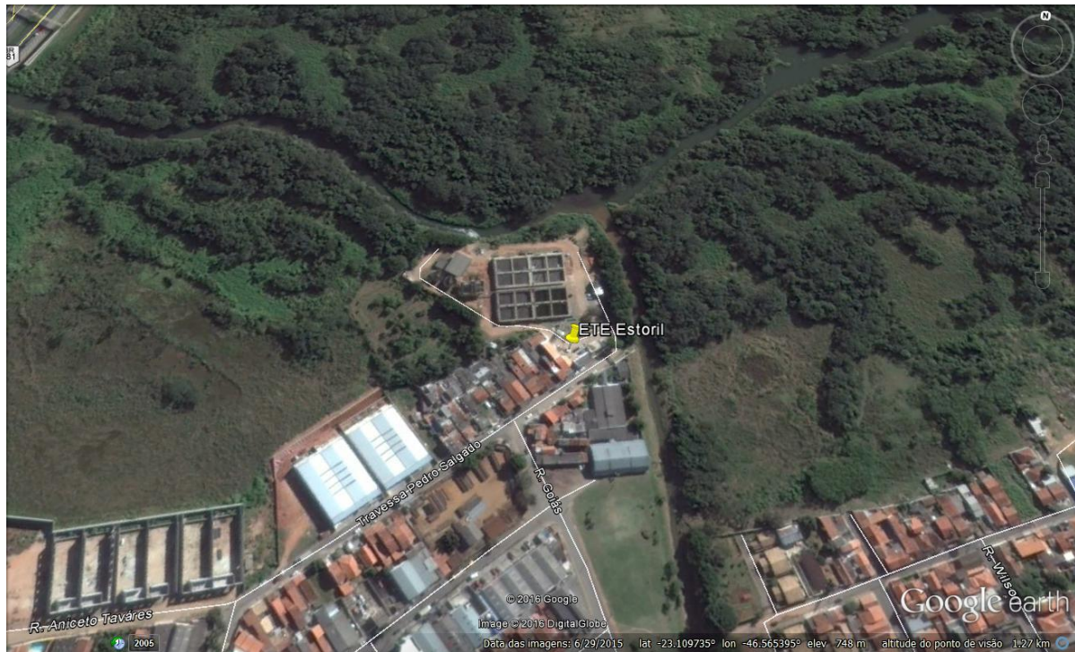
Figura 11 – Imagem de satélite da Estação de Tratamento de Esgoto Estoril
