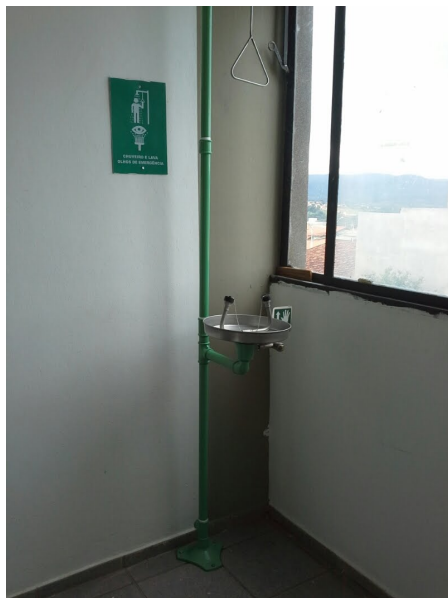
Instalação do Chuveiro de Emergência.
