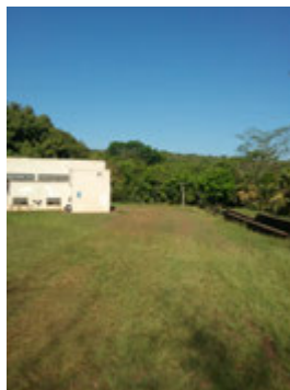
Descrição(7): Vista 4 da captação superficial Anhumas
