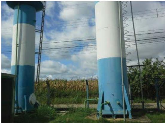
**Descrição(2):** Vista detalhada dos reservatórios sem escada com guarda-corpo
