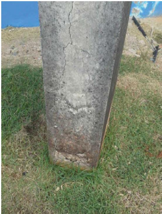
**Descrição(3):** Vista detalhada da estrutura de concreto armado com necessidade de reparo
