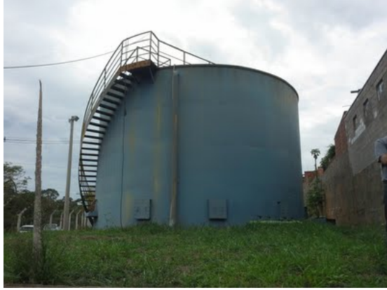
Descrição(3): Reator anaeróbio, filtro biológico e decantador
