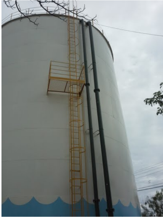
Descrição(2): Escada de acesso e tubulações de entrada
