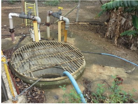
Descrição(3): Aspecto do poço de sucção e antigas sucções de bombas reautoescorvantes (desativadas)
