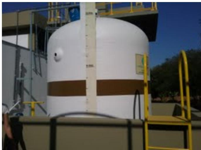
**Descrição(12):** Armazenamento de Purate: Peroxido de hidrogênio e clorato de sódio
