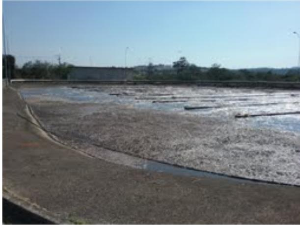
**Descrição(21):** Detalhe do tanque de aeração (com camada espessa de sobre-nadante)
