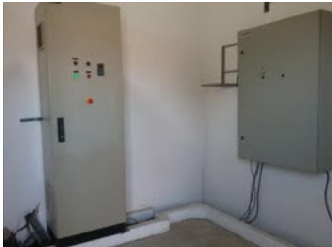
**Descrição(3):** Painéis de acionamento e telemetria
