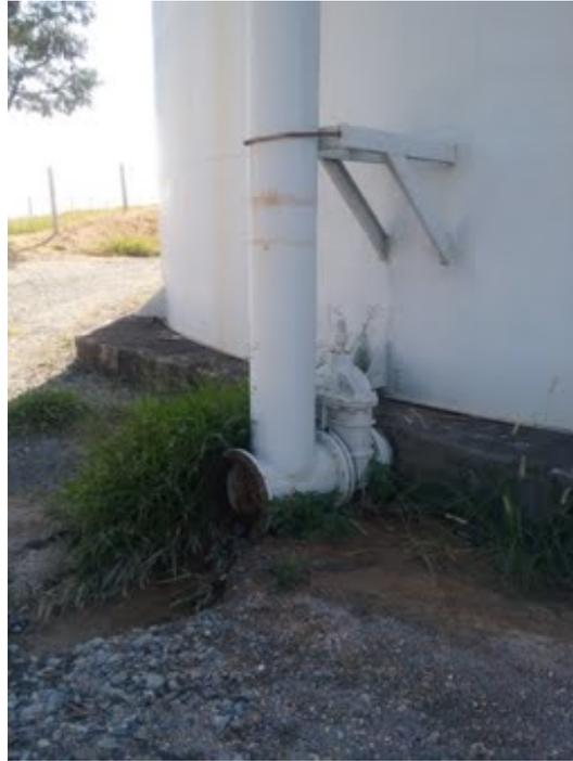
**Descrição(3):** Detalhe do tubo extravasor e da descarga de fundo
