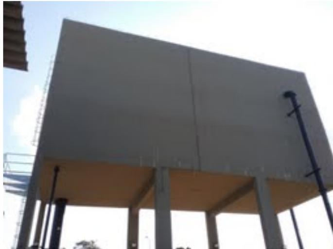
**Descrição(1):** Detalhe das manchas de carbonatação nas paredes de concreto
