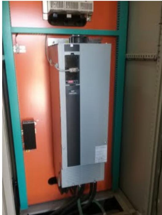
**Descrição(4):** Painel elétrico com inversor
