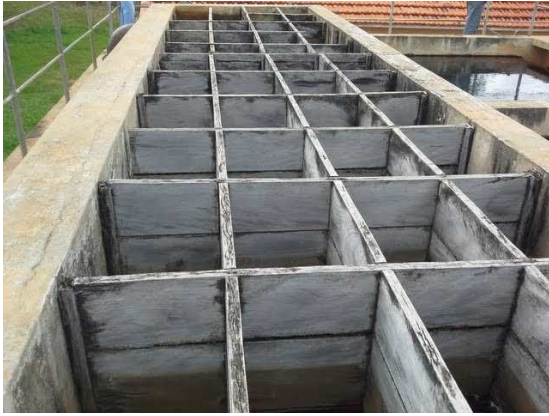
Descrição(3): Flocculador (Módulo1)
