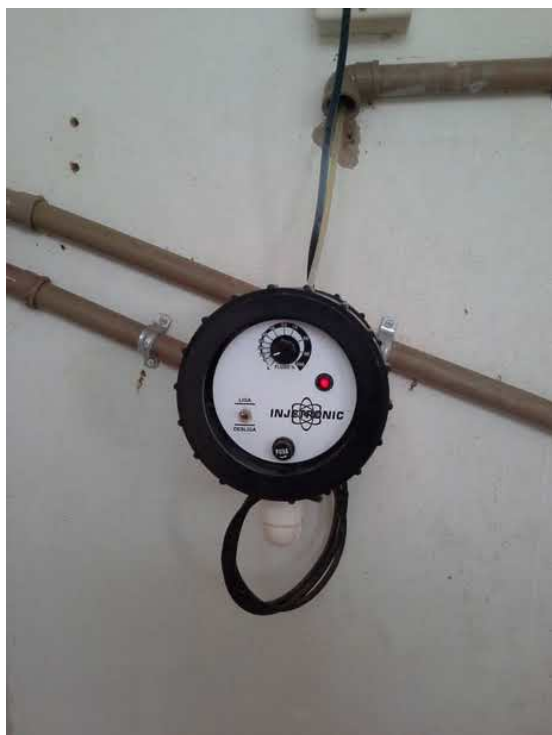
Descrição(13): Dosador Automático de Flúor
