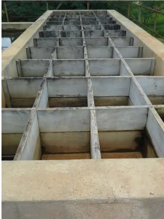
Descrição(5): Floculador (Módulo 2)
